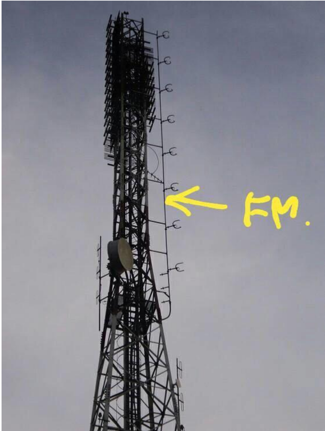
รูปที่ 3.36 รูปร่างของสายอากาศของสถานีวิทยุ อ.ส.ม.ท. นครศรีธรรมราช
