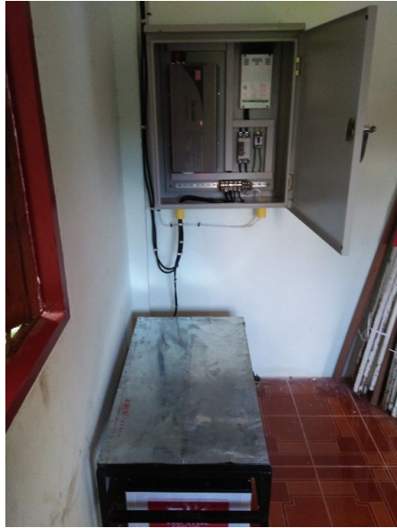
รูปที่ ก๔๙ ระบบไฟฟ้าพลังงานแสงอาทิตย์และระบบส่งเหตุการณ์ ณ ระบบฯ จุดที่ ๘
