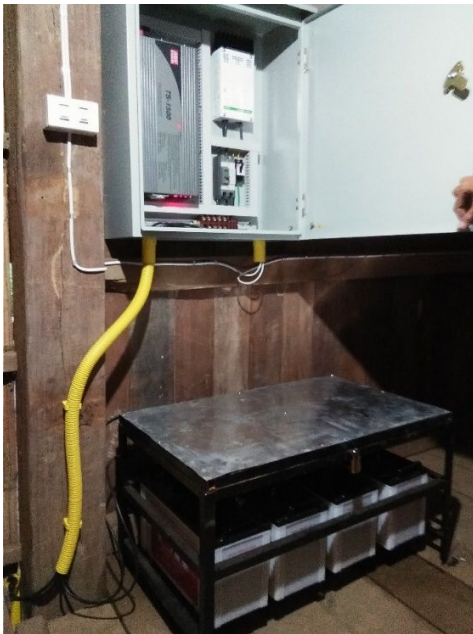
รูปที่ ก๔๕ ตู้ควบคุมระบบไฟฟ้า แบตเตอรี่ และระบบส่งเหตุการณ์ ณ ระบบฯ จุดที่ ๗
