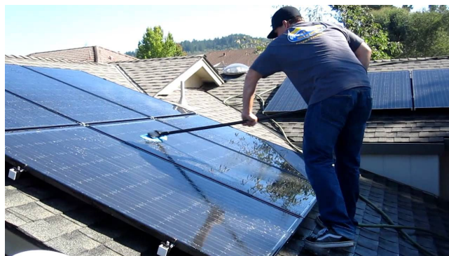
รูปที่ ๔ การทำความสะอาดแผงพลังงานแสงอาทิตย์
