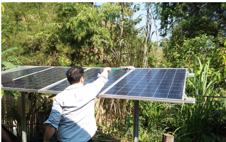
รูปที่ ข๕ สาดิตการทำความสะอาดแผงพลังงานแสงอาทิตย์ ที่ รพ.สต.บ้านกามาผาใต้
