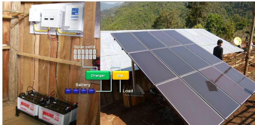
รูปที่ ๙ ระบบไฟฟ้าเซลล์แสงอาทิตย์ที่ติดตั้ง ณ ศศช.บ้านห้วยเกียงน้อย อ.สบเมย จ.แม่ฮ่องสอน
