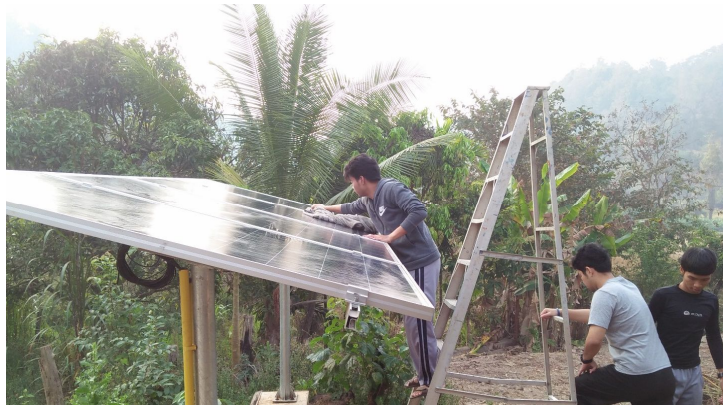
รูปที่ ข๔ สาดิตการทำความสะอาดแผงพลังงานแสงอาทิตย์ ที่ บ้านครูใหญ่ บ้านป่าสัก
