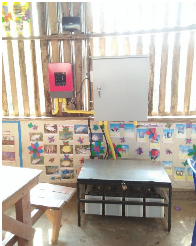
รูปที่ ๓๕๗ ระบบไฟฟ้าพลังงานแสงอาทิตย์และระบบสังเกตการณ์ ณ ระบบฯ จุดที่ ๑๐
