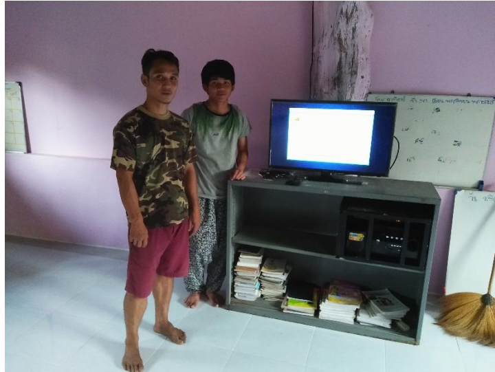
รูปที่ ก๖๖ อุปกรณ์ระบบการสื่อสารด้วยภาพและเสียงที่ติดตั้ง ณ ระบบฯ จุดที่ ๑๒
