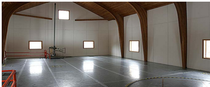
รูปที่ 2-10 การติดตั้งแผ่นกราวด์เพลน
