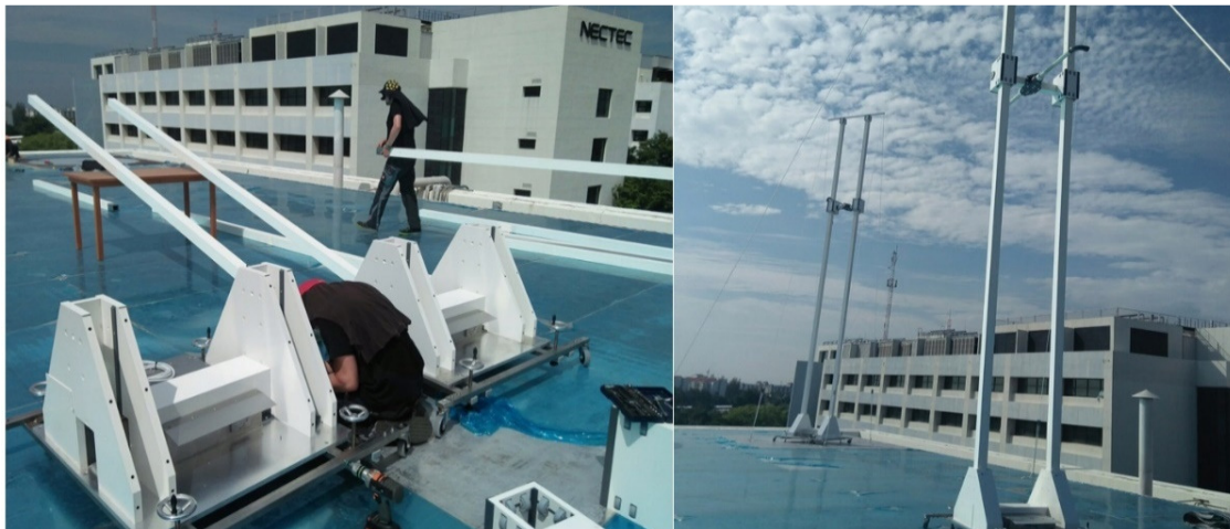
รูปที่ 4-14 แสดงการติดตั้งเสาตั้งสายอากาศ
