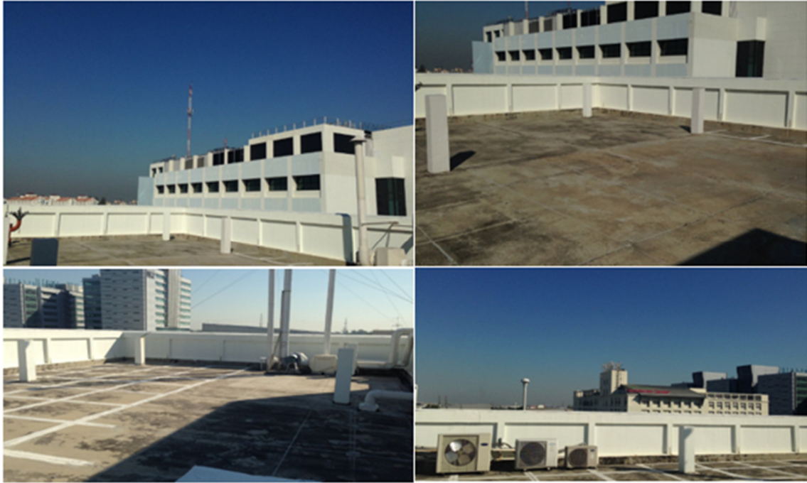
รูปที่ 4-4 แสดงพื้นที่ก่อสร้างที่ได้ดำเนินการปรับปรุงเพื่อรองรับการติดตั้งระบบทดสอบ OATS
