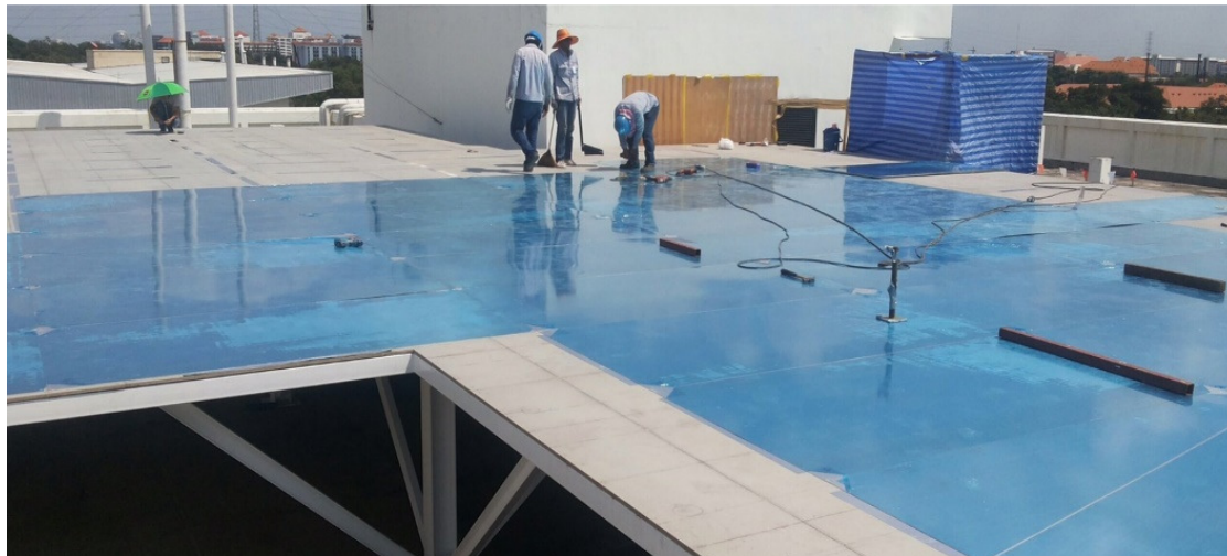
รูปที่ 4-12 แสดงการติดตั้งแผ่นอลูมิเนียมบนผิวแผ่นรับน้ำหนัก
