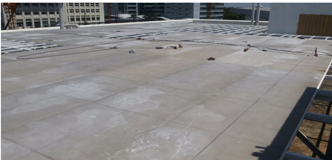
รูปที่ 4-11 แสดงการติดตั้งแผ่นรับน้ำหนักบนโครงสร้าง
