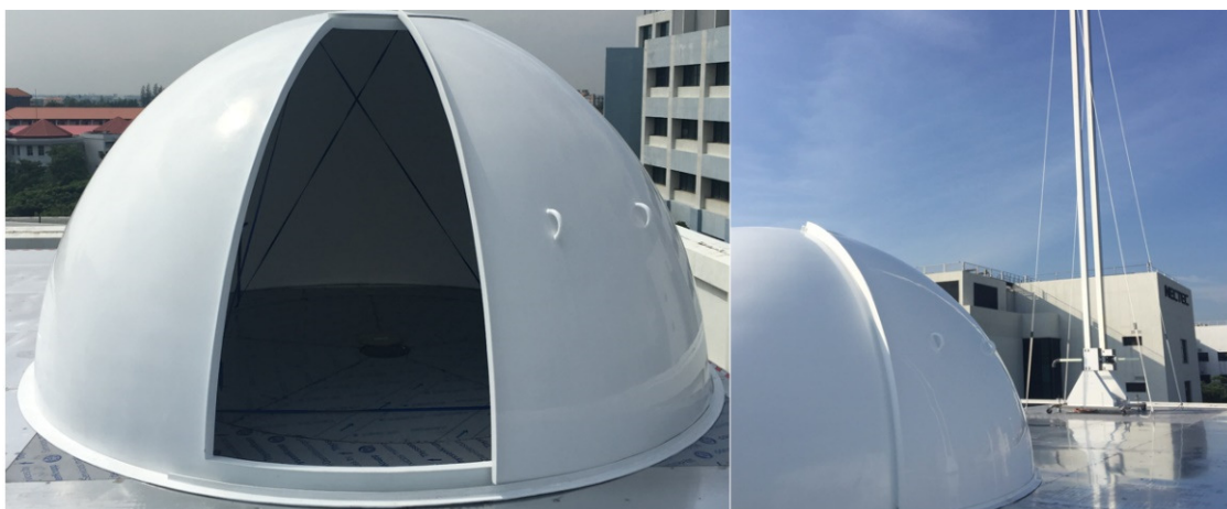
รูปที่ 4-15 การติดตั้งโดมครอบแท่นหมุน
