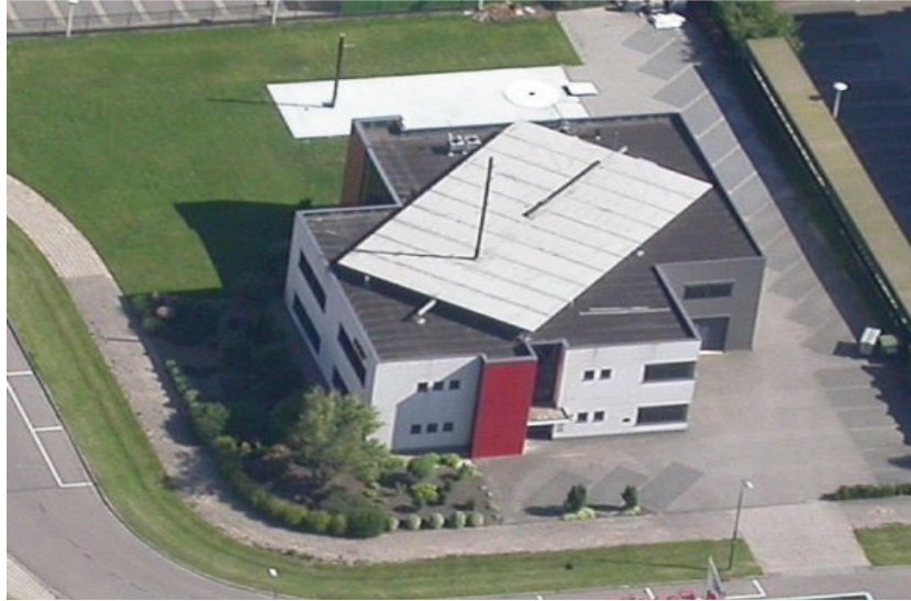
รูปที่ 2-16 โครงสร้างซึ่งตั้งอยู่ในพื้นที่เปิดโล่ง
