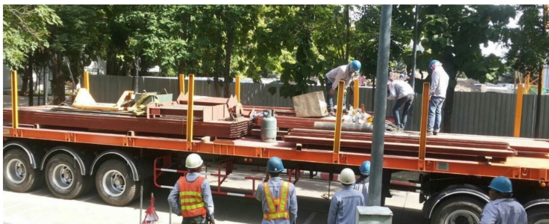
รูปที่ 4-9 การขนส่งโครงสร้างขึ้นติดตั้งบนชั้นดาดฟ้า
