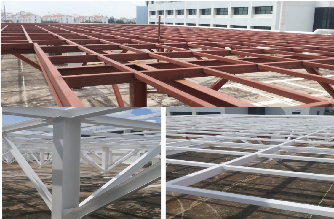
รูปที่ 4-10 การติดตั้งโครงสร้างรับน้ำหนัก
