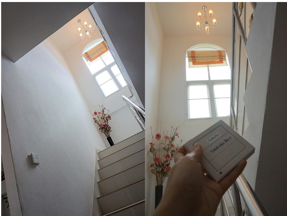
รูปที่ 48 สวิตซ์ที่ติดตั้งใหม่ บริเวณบันได ของบ้านคุณหมอกนกพรรณ จังหวัดสงขลา
