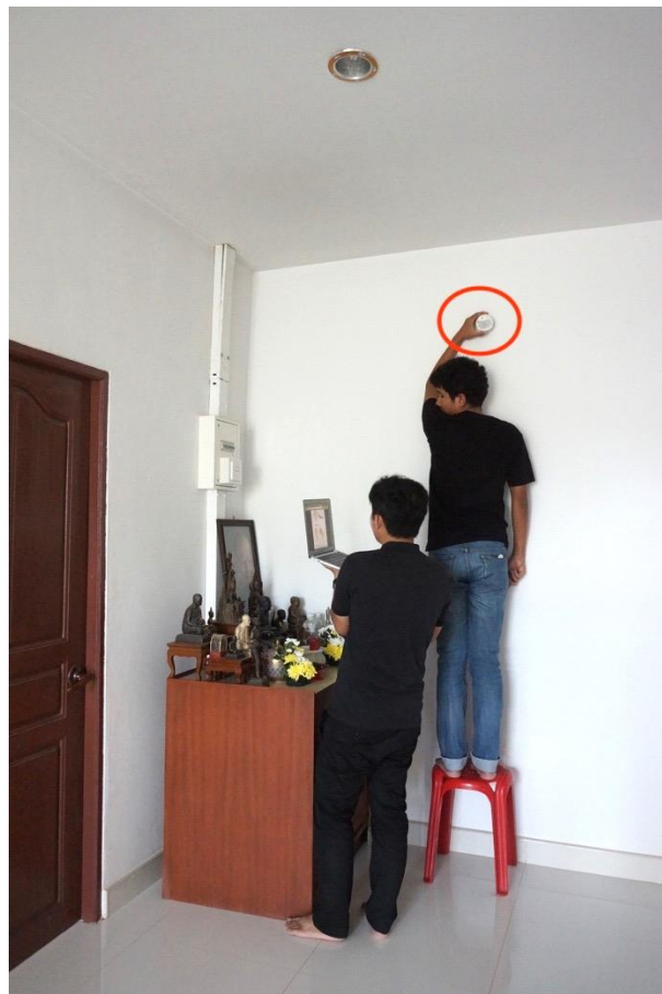
รูปที่ 57 เซนเซอร์ตรวจจับความเคลื่อนไหวและระดับแสงสว่าง ภายในบ้านคุณหมอกนกพรหม จังหวัดสงขลา
