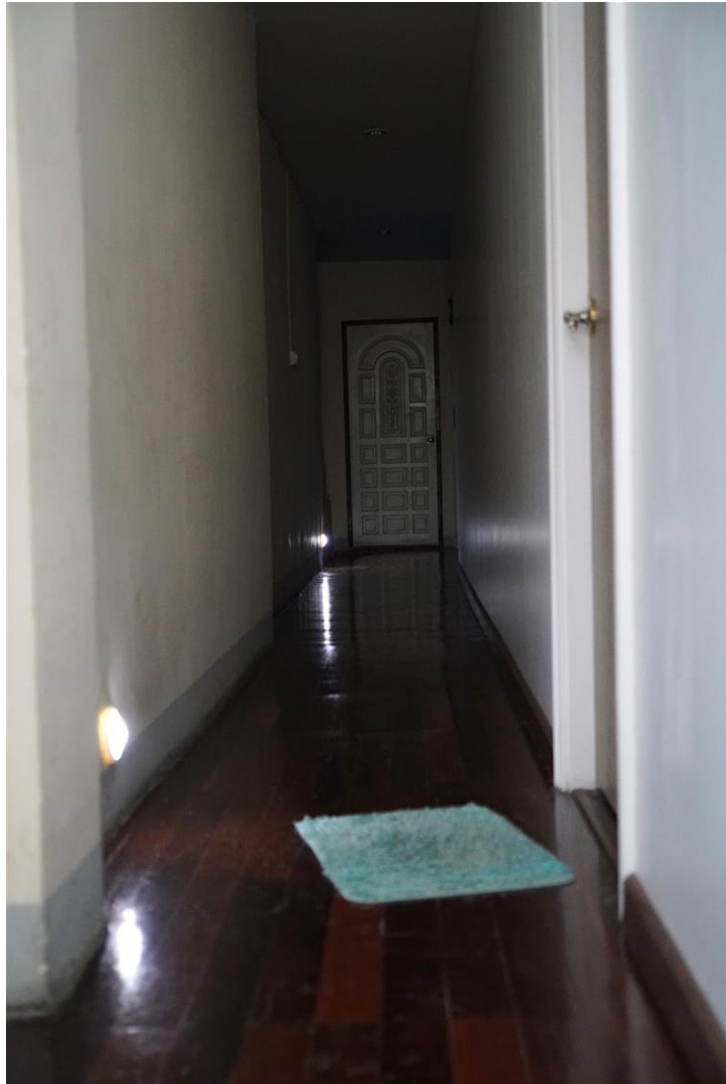
รูปที่ 50 Light Motion Sensor บริเวณทางเดินชั้น 2 ของบ้านคุณแม่อมรพรรณ จังหวัดภูเก็ต
