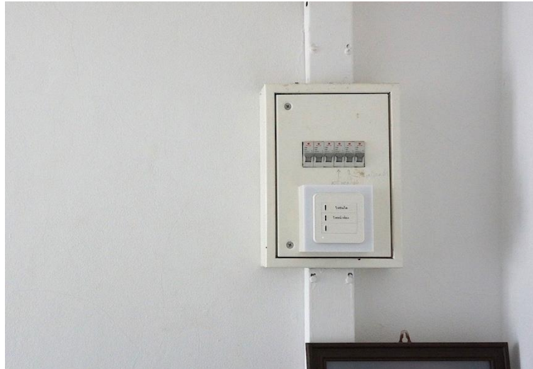
รูปที่ 49 สวิตช์ที่ติดตั้งใหม่ บริเวณโถงชั้น 2 ของบ้านคุณหมอกนกพรรณ จังหวัดสงขลา
