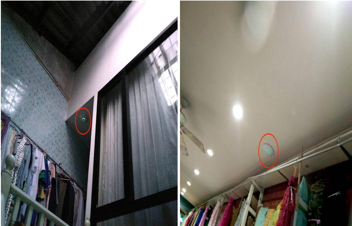
รูปที่ 39 บริเวณที่ติดตั้ง Access Point ของบ้านคุณแม่อมรพรรณ จังหวัดภูเก็ต
