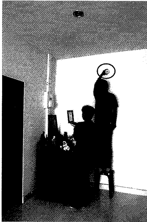
รูปที่ 14 เซนเซอร์ตรวจจับความเคลื่อนไหวและระดับแสงสว่าง ภายในบ้านคุณหมอกนกพรรณ จังหวัดสงขลา สรุปติดตั้งเซนเซอร์ 8 จุด การติดตั้ง Digital Door Lock
