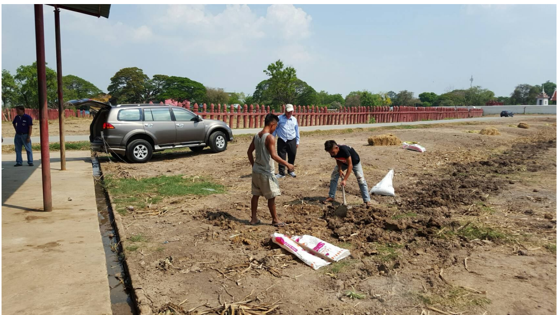
ภาพที่ 15 การเกลี่ยดินกลับทับตัวตรวจรู้แบบแผ่นกลมแบนให้มีสภาพพื้นดินเหมือนเดิมเพื่อตรวจจับการเคลื่อนไหวของช้าง
