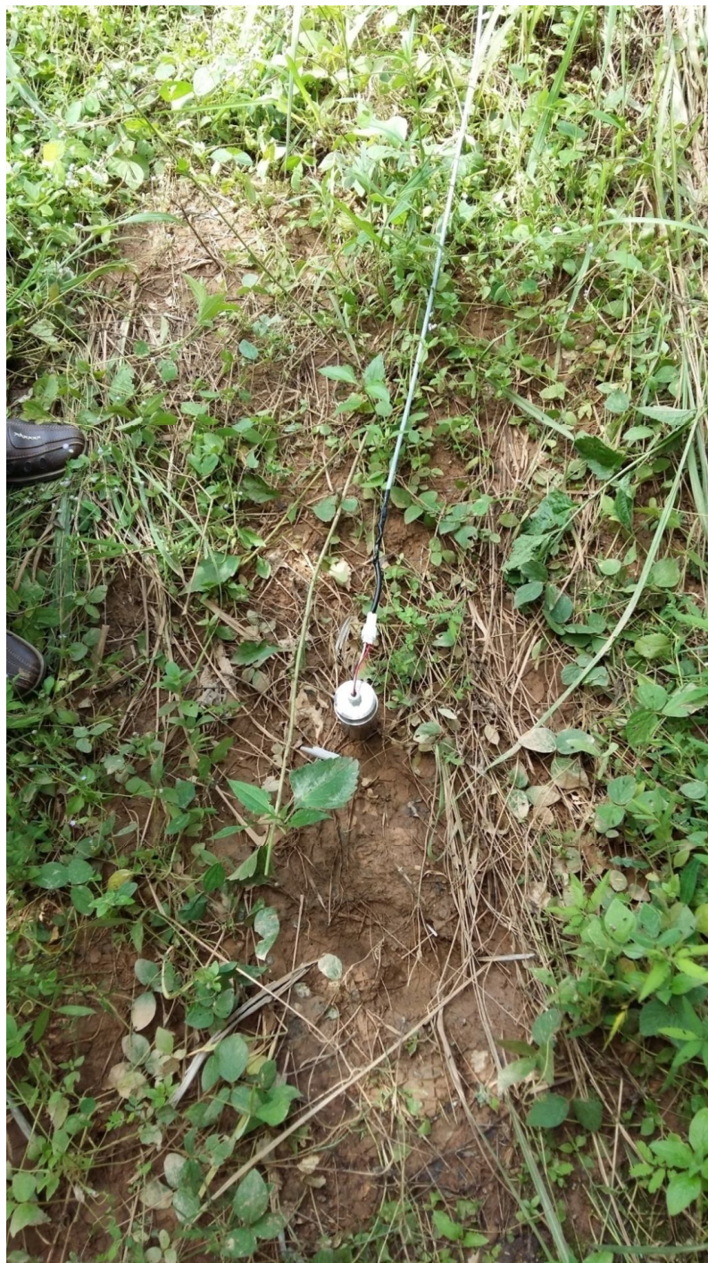
ภาพที่ 52 การติดตั้งตัวตรวจรู้แบบจีไอโฟน
