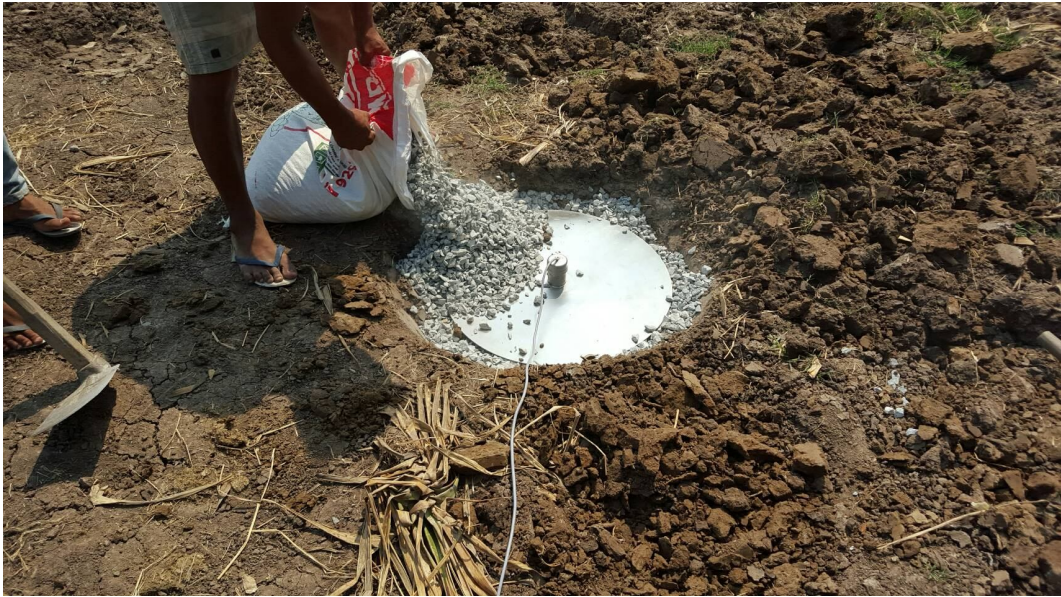
ภาพที่ 14 การกลับฝังตัวตรวจรู้แบบแผ่นกลมแบนบนหลุมเพื่อตรวจจับการเคลื่อนไหวของช้าง
