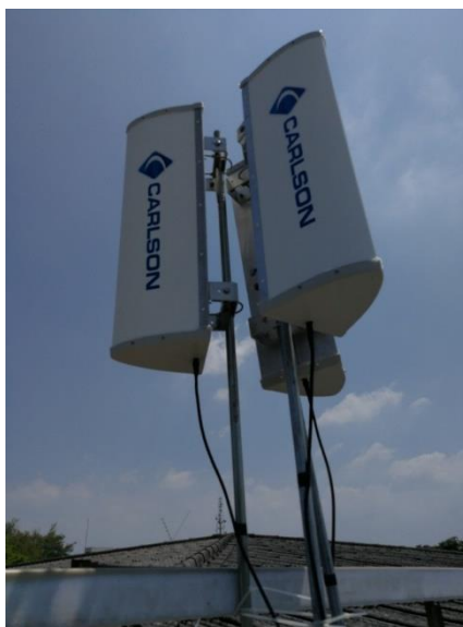
รูปที่ 3.21: สายอากาศแบบแบ่งส่วนหรือเซ็กเตอร์แบบ 120 องศา (120-degree sector antenna) ของเครื่องสถานีฐาน
