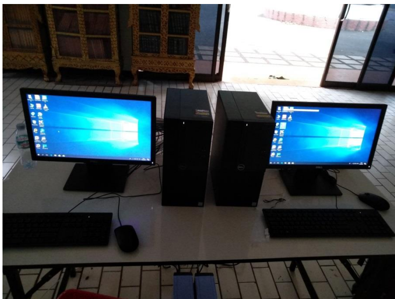
ภาพที่ 4.1.60 ภาพประกอบการติดตั้งระบบคอมพิวเตอร์
