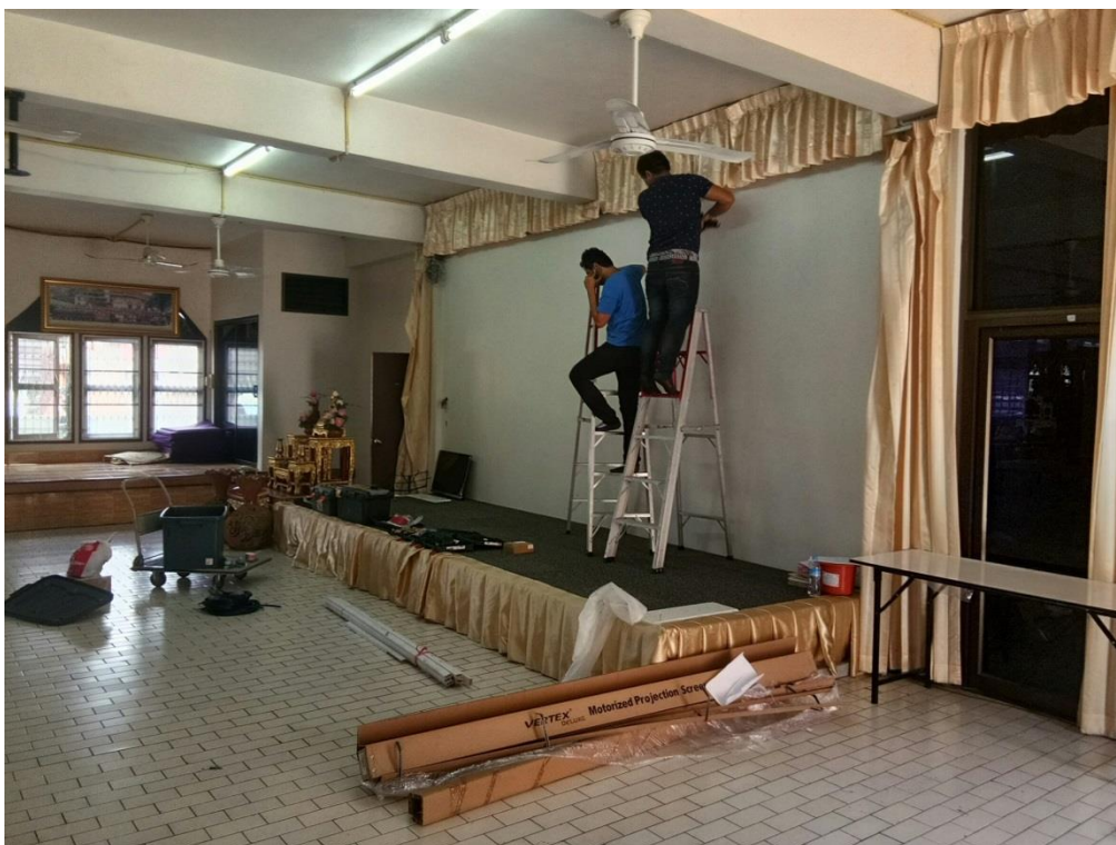
ภาพที่ 4.1.59 ภาพประกอบการติดตั้งโปรเจคเตอร์
