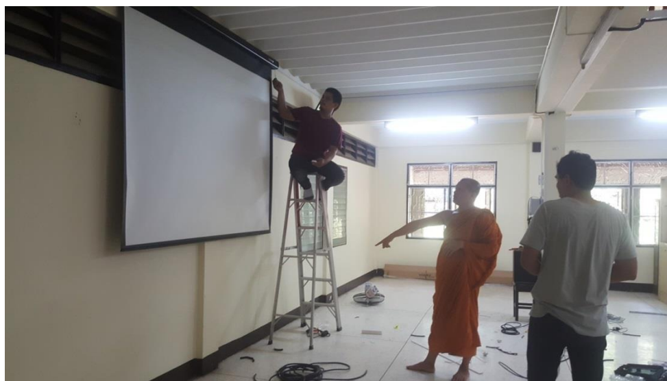
ภาพที่ 4.1.65 ภาพประกอบการติดตั้งโปรเจคเตอร์
