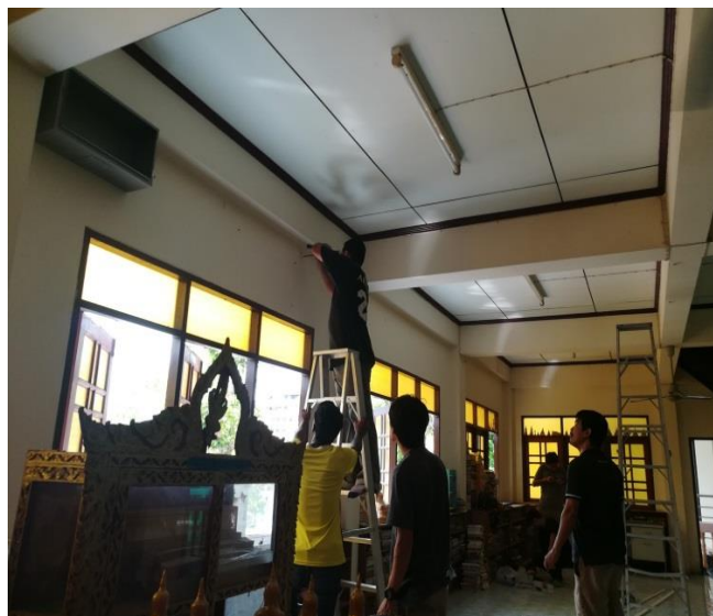
ภาพที่ 4.1.33 ภาพประกอบการติดตั้งอุปกรณ์ของระบบอินเทอร์เน็ต
