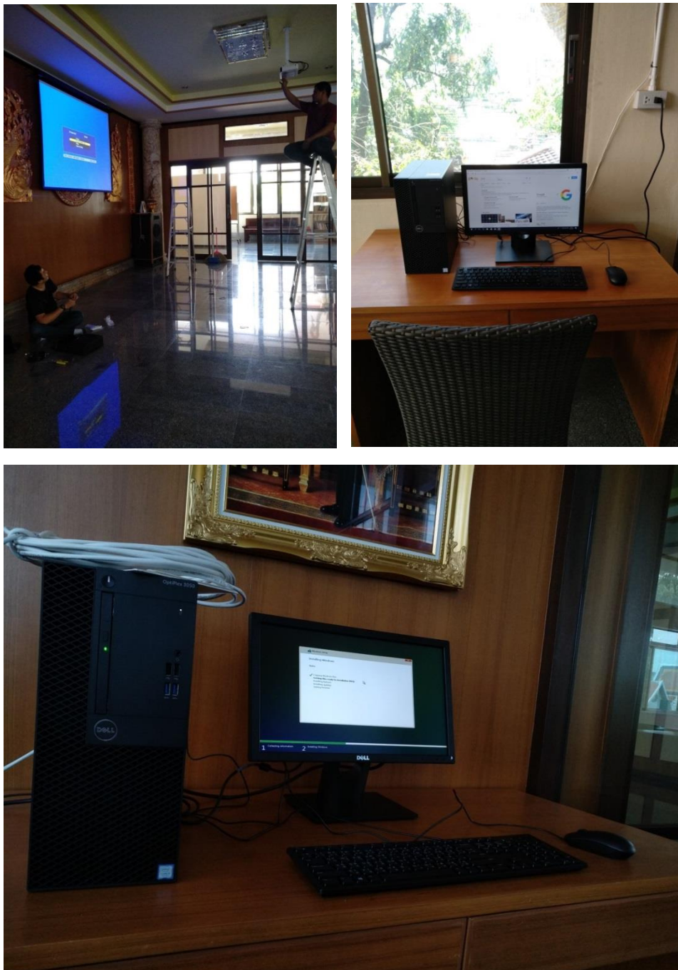
ภาพที่ 4.1.24 ภาพประกอบการติดตั้งระบบคอมพิวเตอร์
