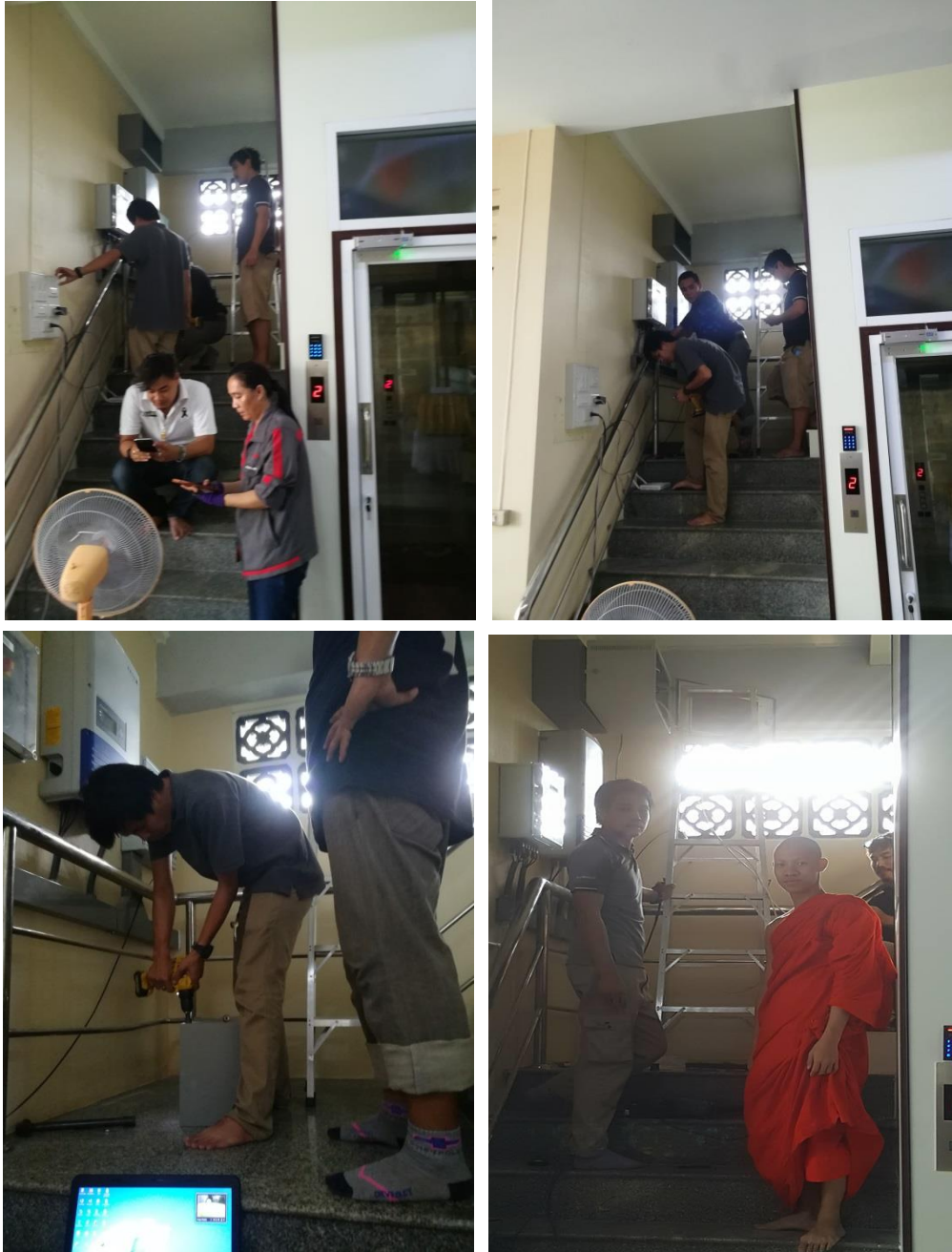
ภาพที่ 4.1.21 ภาพประกอบการติดตั้งอุปกรณ์ของระบบอินเทอร์เน็ต
