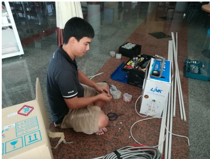
ภาพที่ 4.1.39 ภาพประกอบการติดตั้งอุปกรณ์ของระบบอินเทอร์เน็ต
