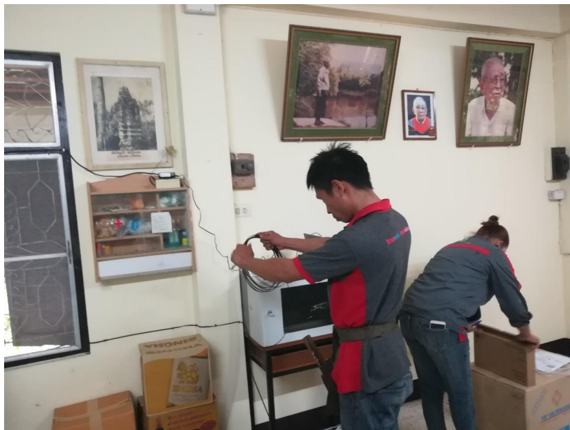
ภาพที่ 4.1.63 ภาพประกอบการติดตั้งอุปกรณ์ของระบบอินเทอร์เน็ต
