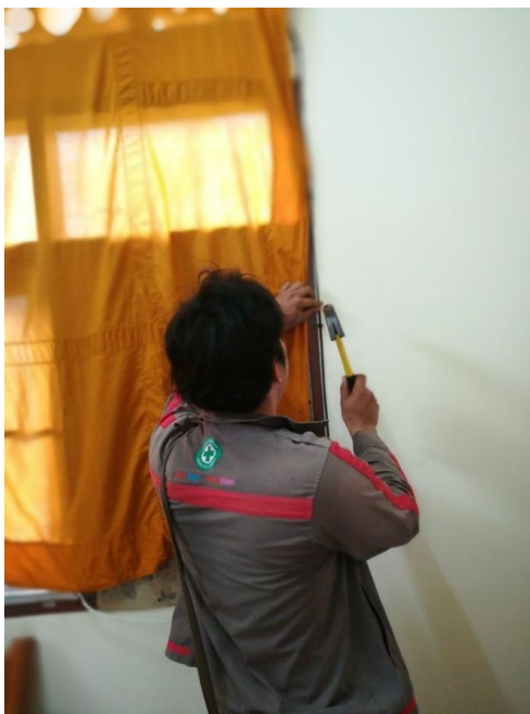
ภาพที่ 4.1.45 ภาพประกอบการติดตั้งอุปกรณ์ของระบบอินเทอร์เน็ต
