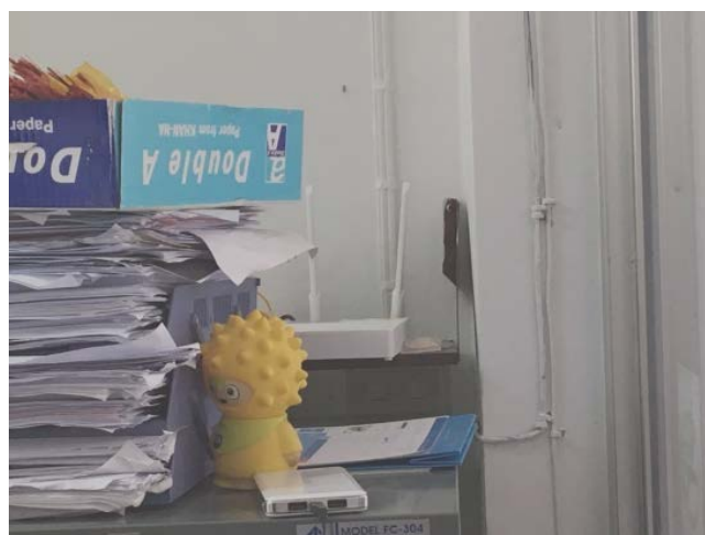
อุปกรณ์ Router ส่งรายงาน ระบบบัญชี ผ่านอินเทอร์เน็ต ADSL ของ TOT
