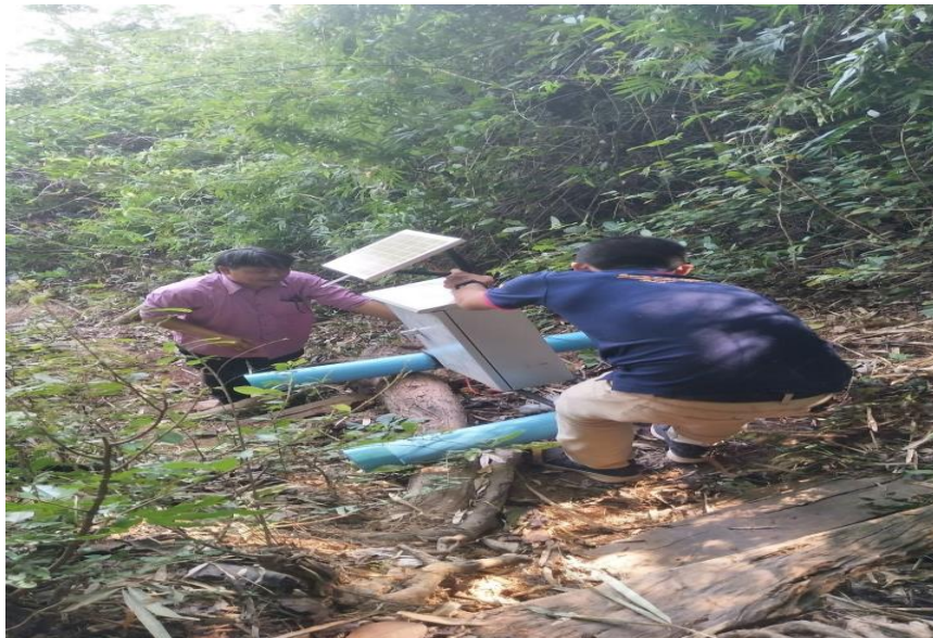
ภาพที่. 3-28 นำไปติดตั้งของชุดตรวจวัดคุณภาพน้ำที่บ้านวังโพธิ์
