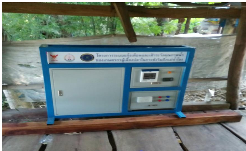
ภาพที่.3-24 ตำแหน่งในการติดตั้งชุดควบคุมและชุดเติมอากาศที่บ้านวังโพธิ์
