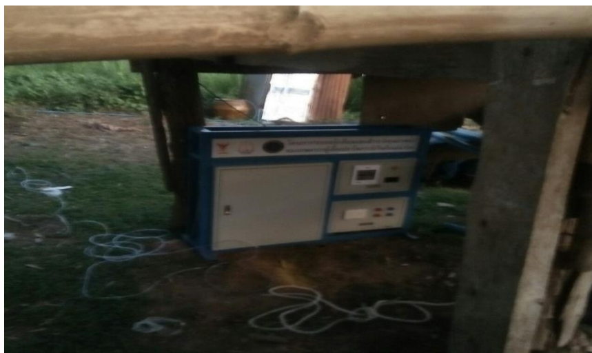
ภาพที่.3-35 ตำแหน่งในการติดตั้งชุดควบคุมและชุดเติมอากาศที่บ้านหาดกวน
