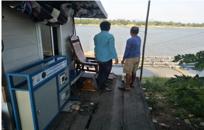
ภาพที่ 3-45 ตำแหน่งในการติดตั้งชุดควบคุมและชุดเติมอากาศที่บ้านห้อม
