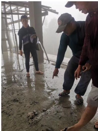
รูปที่ 63: กำหนดแนวก่อสร้างผนังเบา (ขวา) ผู้รับเหมาทำงานแก้ไข
