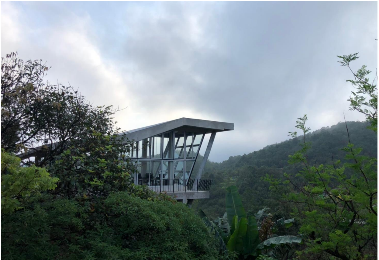
รูปที่ 68: บรรยากาศภายในอาคารหลังการก่อสร้างเสร็จสิ้น (5)
