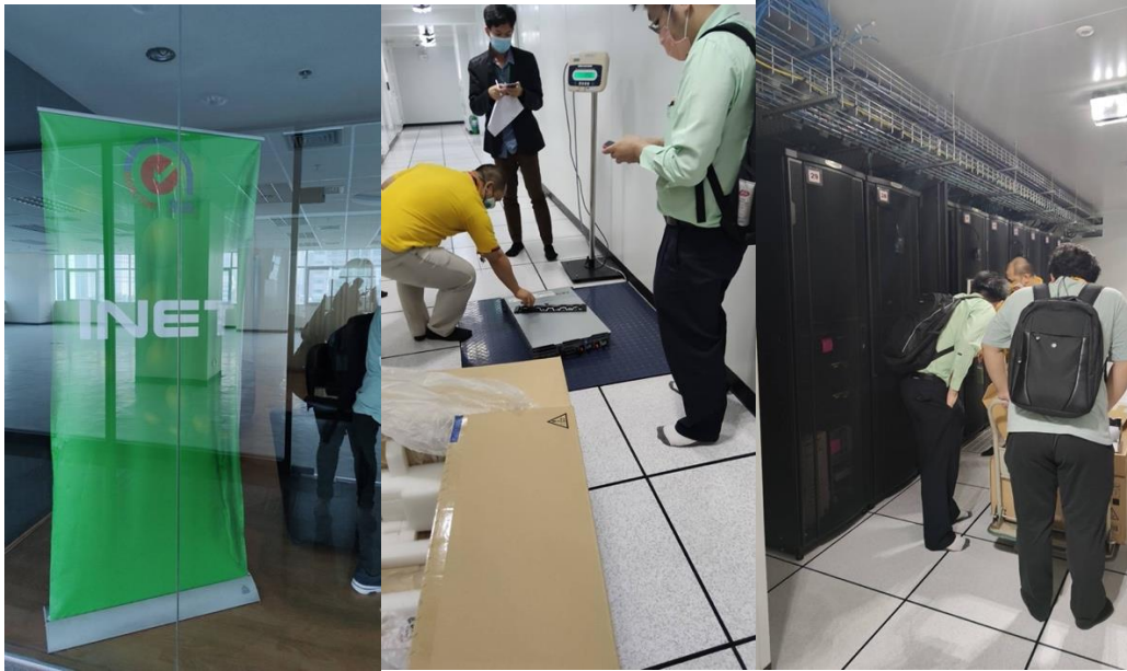
รูปที่ 48 ขั้นตอนการซ้มน้ำหนักเครื่องคอมพิวเตอร์แม่ข่ายก่อนนำมาติดตั้งที่ตู้ Rack
