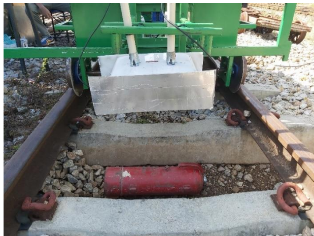
รูปที่ 144 การวางถังดับเพลิงไว้ในกลางหลุมรางรถไฟที่ยังไม่มีการฝังกลบ
