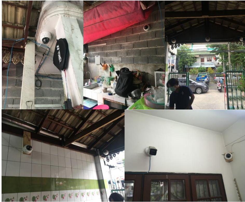
รูปที่ 153 ตำแหน่งการติดตั้งกล้องแต่ละตัว
