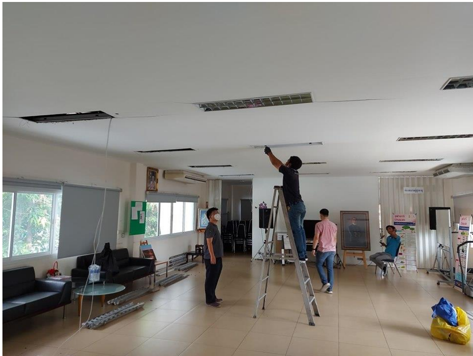
ภาพที่ 53 ติดตั้งอุปกรณ์ ณ ชมรมผู้สูงอายุ ศูนย์บริการสาธารณสุขที่ 56 ทับเจริญ
