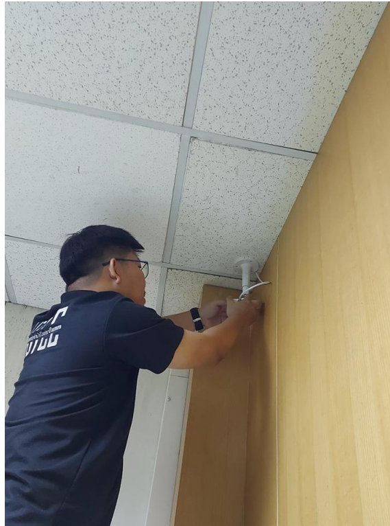
ภาพที่ 24 การปรับองศาการติดตั้งของ RTLS Anchor ณ ตำแหน่งต่าง ๆ
