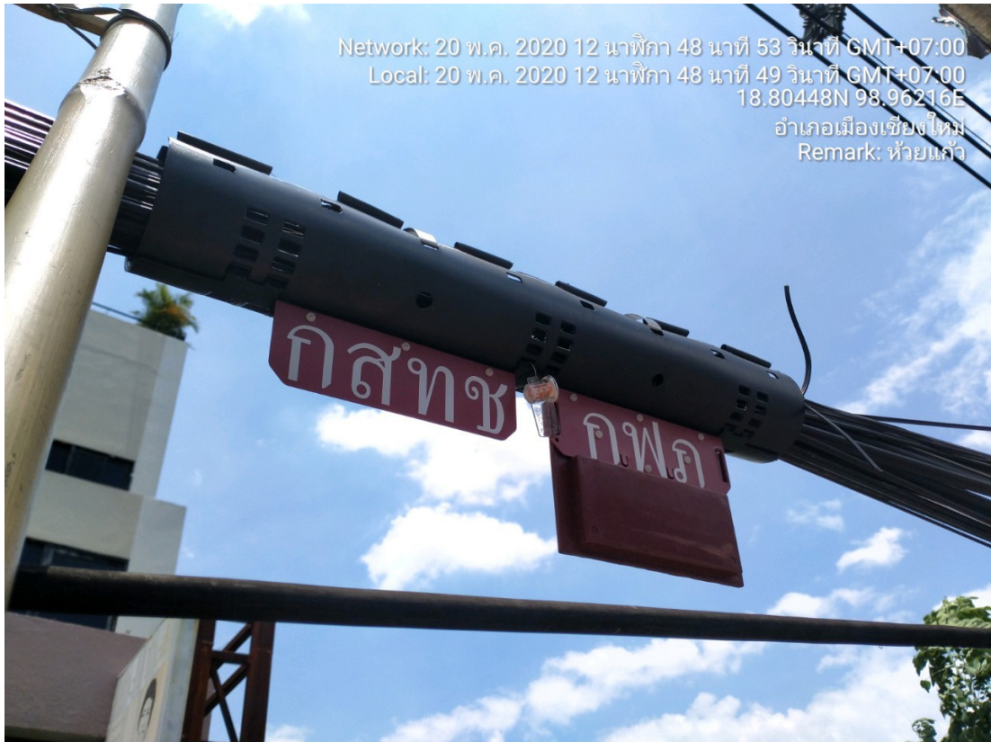
รูปที่ 2 ท่อป้องกันที่ติดตั้งแล้ว มีแผ่นป้ายชื่อหน่วยงานและแผ่นป้าย RFID (สีแดงเข้ม)
