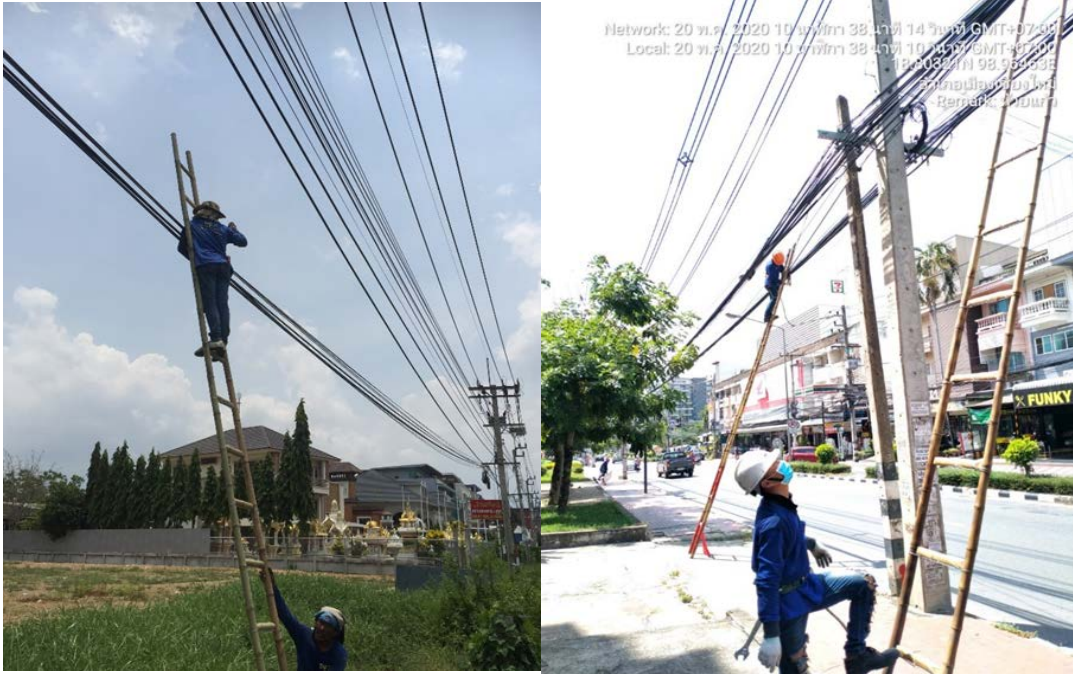
รูปที่ 5 การทำงานขณะติดตั้งอุปกรณ์ตรวจสอบสายสื่อสาร
