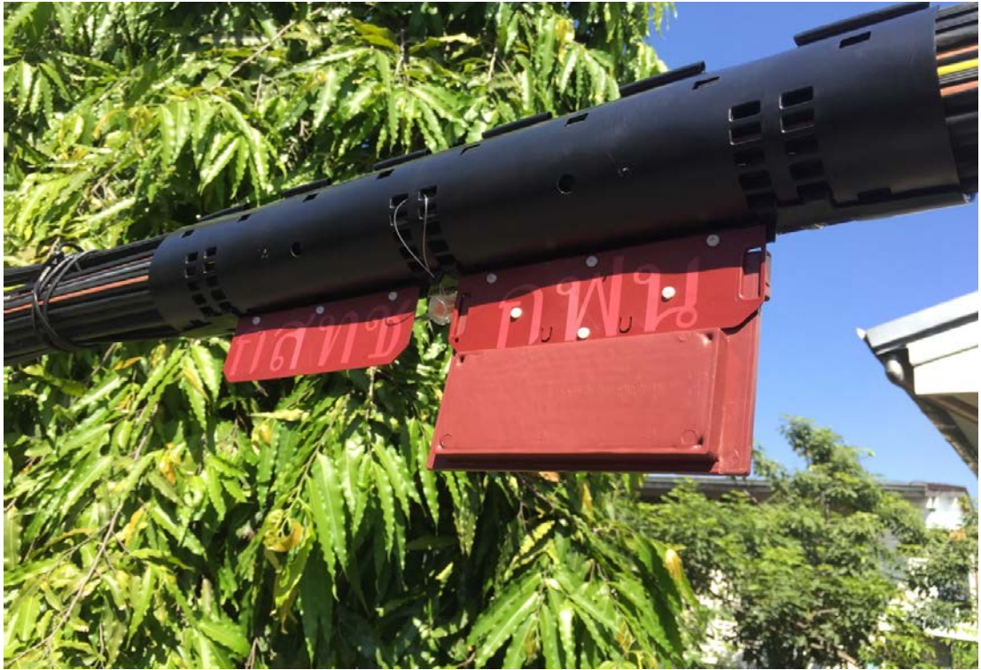
รูปที่ 76 ท่อป้องกันที่ติดตั้งแล้วภายในซอยสายลม
