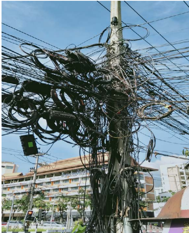
รูปที่ 80 สายสื่อสารพาดติดเสาไฟฟ้าก่ดทับสายไฟฟ้าแรงต่ำทำให้เกิดไฟฟ้ารั่ว
