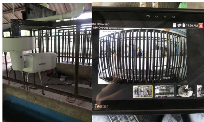
รูปที่ 43 การติดตั้งกล้องในระดับภาคอุตสาหกรรมบริเวณด้านข้าง
