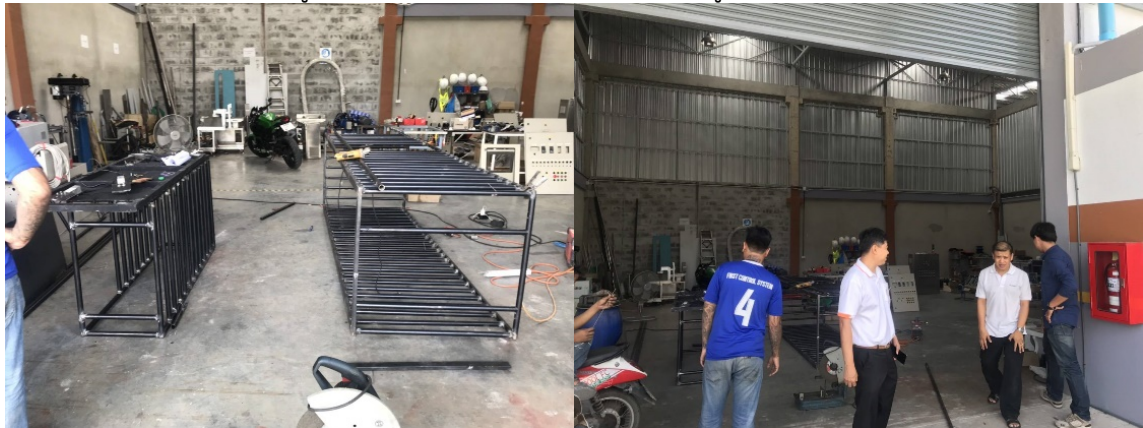
รูปที่ 36 การสร้างกรงหมูจริงภายหลังการออกแบบเสร็จสิ้น
