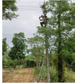
รูปที่ 30 การติดตั้งอุปกรณ์ LoRaWAN Gateway บนเสาส่งสัญญาณ
