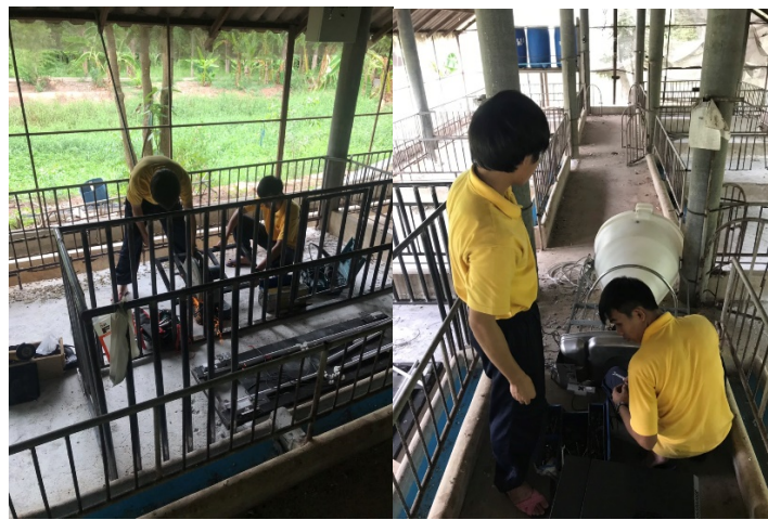
รูปที่ 38 ขั้นตอนการติดตั้งกรงหมูภายในเล้าหมูอาสาสมัคร (2)
