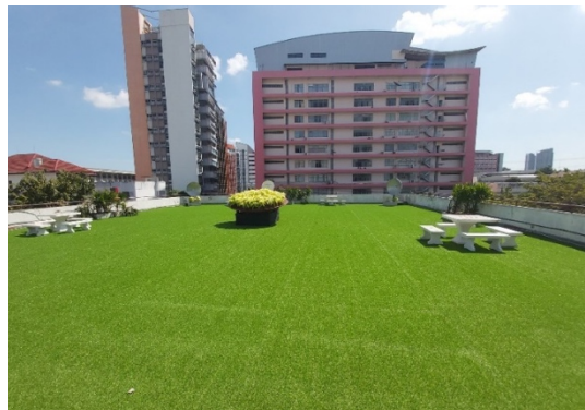
รูปที่ 9.13 สถานที่จริงของตึกฟ้าตีวิศวกรรมศาสตร์สำหรับการทดสอบเรดาร์ตรวจจับโดรน
