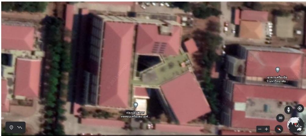
รูปที่ 22 รูปจากด้านบนของอาคาร F11
