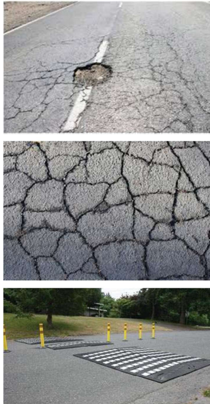
ภาพที่ 3-1 ตัวอย่างหลุม รอยแยก และลูกกระขนาดบนถนน [2]
