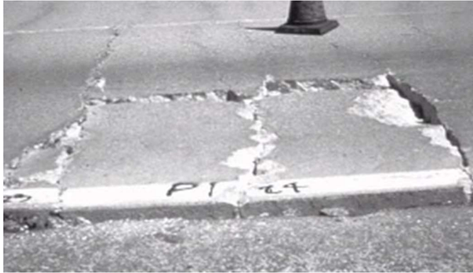
ภาพที่ 2-2 ตัวอย่างความเสียหายบนผิวทางจราจรชนิดรอยแตกกระแทก (Punch-out)
