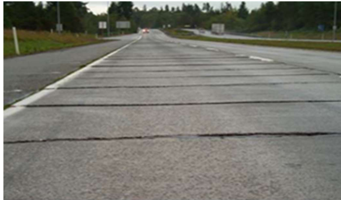
ภาพที่ 2-14 ตัวอย่างความเสียหายชนิดรอยเลื่อนต่างระดับ (Faulting)
