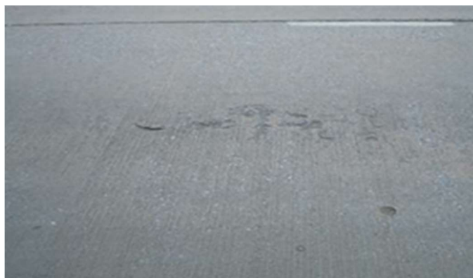
ภาพที่ 2-18 ความเสียหายชนิดผิวหลุดลอก (Scaling)
