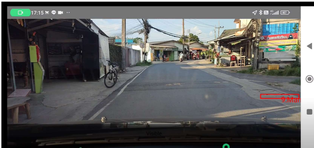
ภาพที่ 17-4 การตรวจจับความผิดปกติบนผิวจราจรของถนนกะทู้-นาเกาะ
