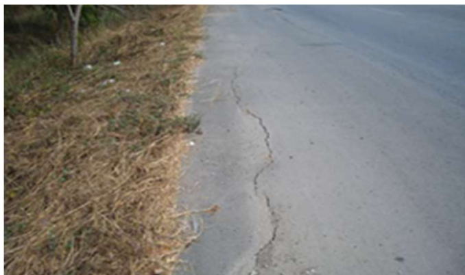
ภาพที่ 2-24 ตัวอย่างความเสียหายชนิดการทรุดตัวต่างระดับของไหล่ทาง (Lane to Shoulder Drop off)
