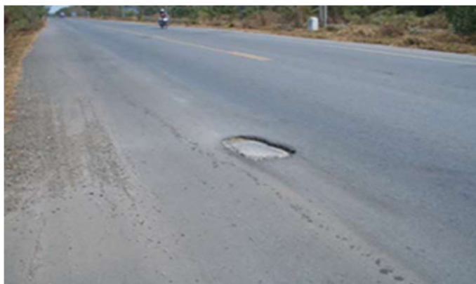
ภาพที่ 2-20 ตัวอย่างความเสียหายชนิดหลุมบ่อ (Potholes)
