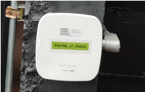
รูปที่ 52 Access Point ที่รองรับ 4G และ 5G พร้อมเดินสายและติดตั้ง
