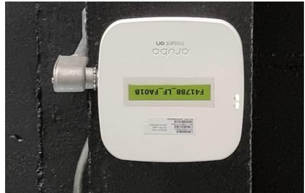
รูปที่ 52 Access Point ที่รองรับ 4G และ 5G พร้อมเดินสายและติดตั้ง
