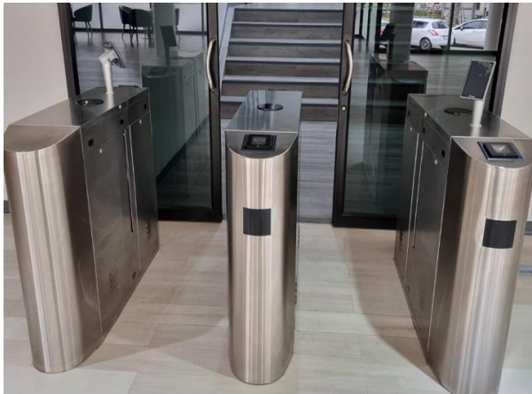
รูปที่ 54 ระบบควบคุมการเปิดปิดประตูด้วยใบหน้า
