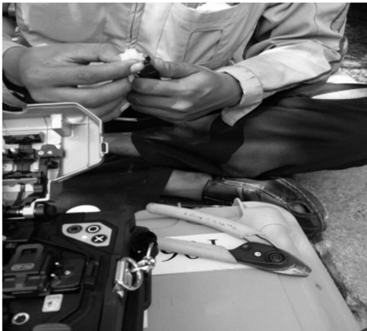
รูปที่ 4.15 การปลอกสาย Fiber Optic ให้เห็นแค่เส้นใยแก้ว
