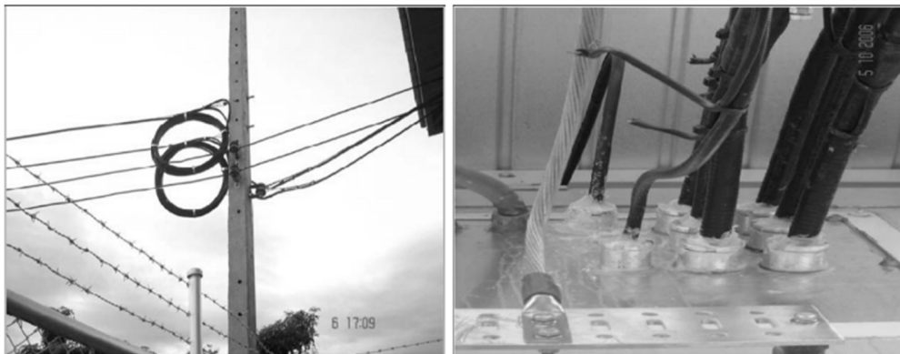
รูปแสดงการ loop สายและการนำเคเบิลเข้าสถานีแบบ Container
