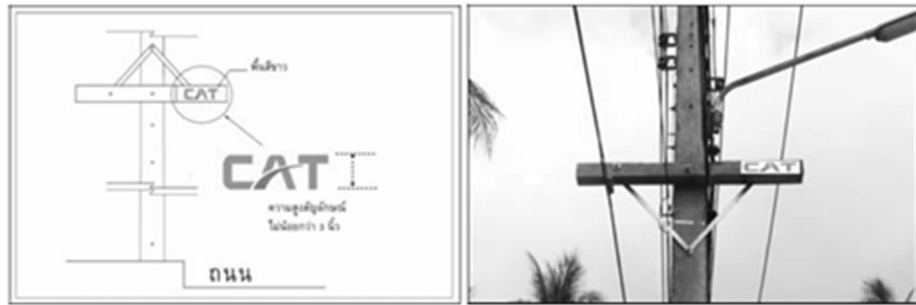
รูปแสดงการติดตั้งไม้คอนสาย
