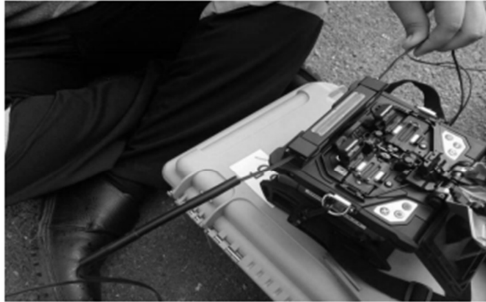
รูปที่ 4.17 ทำการหลอมละลายเพื่อหุ้มด้วยท่อหด
