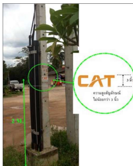
รูปแสดงเสาคอนกรีตและการพ่นสัญลักษณ์
