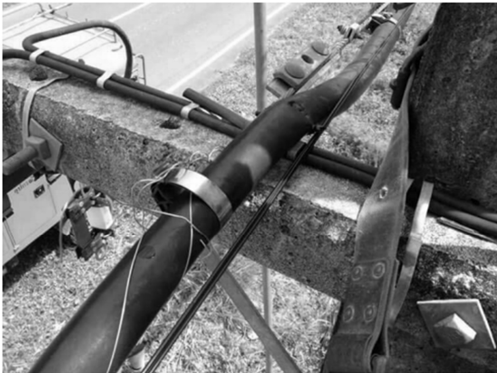
ความเสียหายที่เกิดจากขั้นตอนหรือการปฏิบัติการติดตั้งเคเบิลฯ ไม่ถูกวิธี
