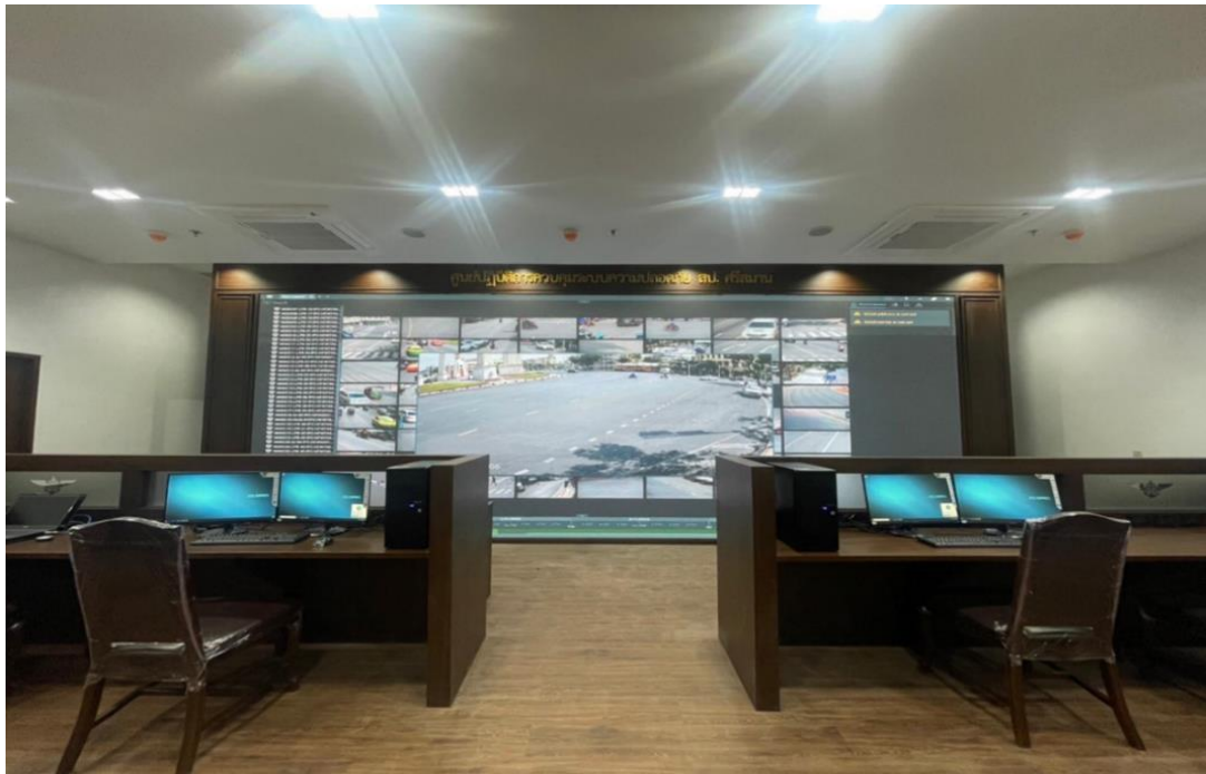
รูปที่ 4.13 แสดงผลจากการเชื่อมต่อเครือข่ายผ่านระบบจอแสดงภาพแอลอีดี ขนาด 3X6 ม.
