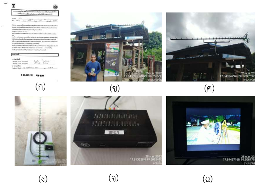
รูปที่ 3-32 แสดงผลการติดตั้งและการรับชมเนื้อหาผ่านสื่อฯ อำเภอวังชิ้น จังหวัดแพร่ โดยติดตั้งสายอากาศชนิด YAGI-27E พร้อมกล่องรับสัญญาณ (Set top box) (ก) แบบสอบถามหลังได้รับการติดตั้ง (ข) รูปถ่ายครัวเรือนที่ได้รับการติดตั้ง (ค) รูปถ่ายตำแหน่งที่ติดตั้งสายอากาศบนตัวบ้าน (ง) อุปกรณ์ที่ใช้ติดตั้งสำหรับครัวเรือนเป้าหมาย (จ) กล่องรับสัญญาณที่ใช้ติดตั้ง (ฉ) ทดสอบสัญญาณในการรับชมผ่านสื่อโทรทัศน์ระบบดิจิทัล
