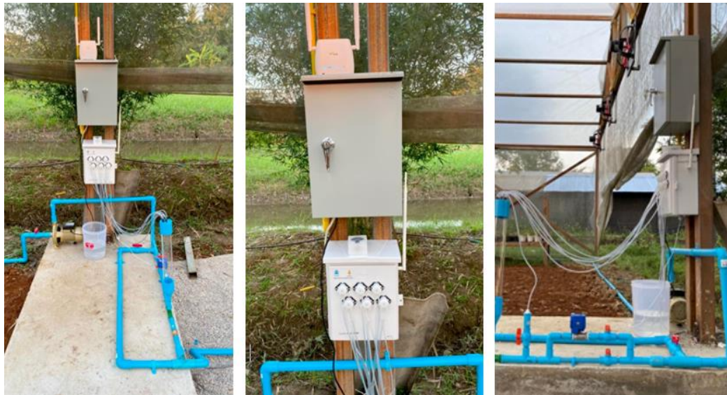
รูปที่ ๔.๑๑ ระบบการให้ปุ๋ยน้ำทางท่อในโรงเรือนปลูก Blackberry และ Raspberry
