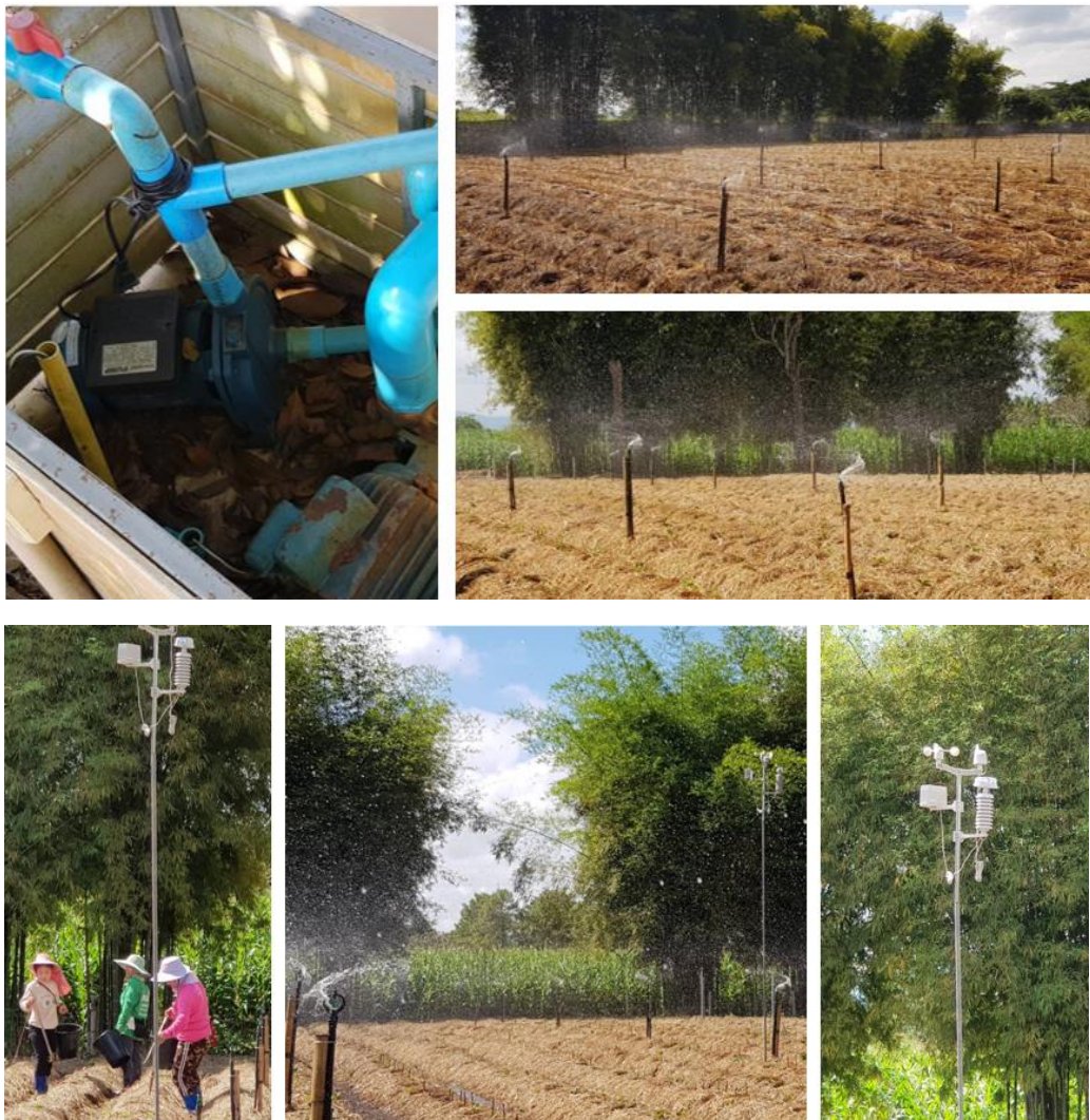
รูปที่ ๔.๑๕ ระบบการให้น้ำอัตโนมัติแบบ IoT และ Weather Station ในแปลงปลูก Strawberry กลางแจ้ง
