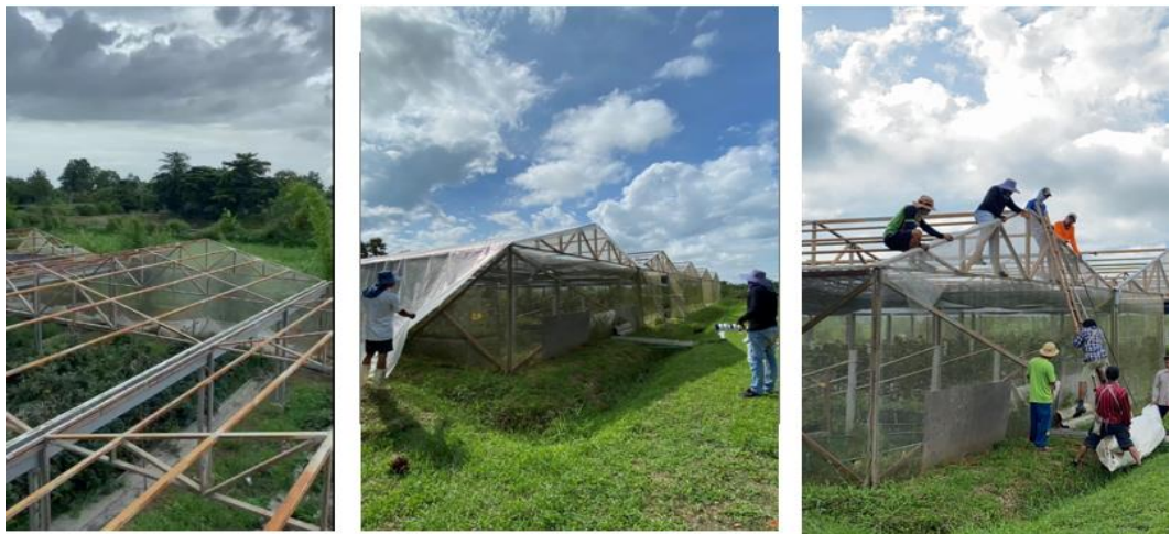
รูปที่ ๔.๖ การติดตั้งพลาสติกกันความร้อนหลังคาโรงเรือน โดยการสนับสนุนจาก บริษัท วิสและบุตร จำกัด
