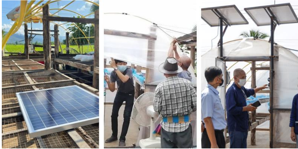
รูปที่ ๔.๘ การติดตั้งอุปกรณ์ของโครงการเพื่อประยุกต์ใช้กับโรงอบแห้งพลาสติกพลังงานแสงอาทิตย์แบบภูมิปัญญาชาวบ้าน
