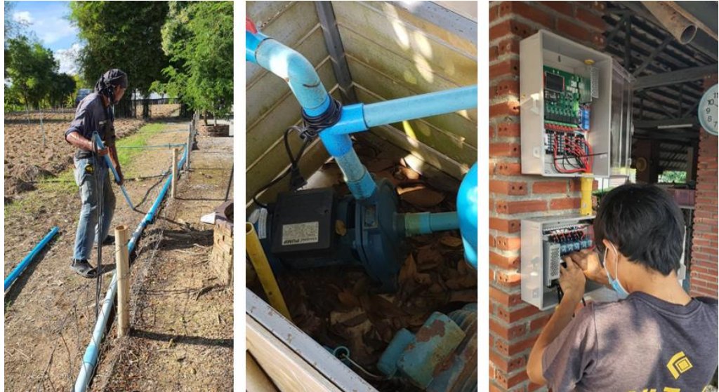
รูปที่ ๔.๔ การติดตั้งอุปกรณ์และระบบการให้น้ำอัจฉริยะของ Organic Strawberry Fam.
