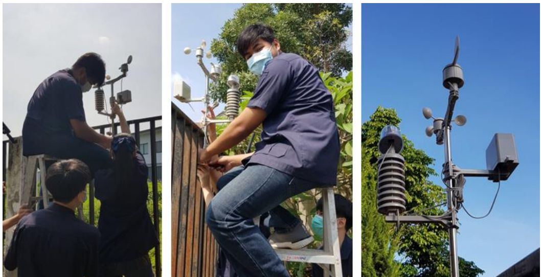
รูปที่ ๔.๗ การติดตั้ง Weather Station โดยนักศึกษาช่วยงานโครงการจากสำนักวิชาเทคโนโลยีสารสนเทศ
