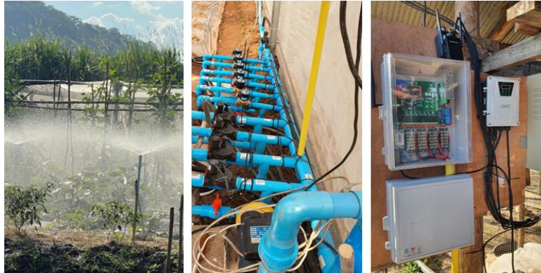
รูปที่ ๓ อุปกรณ์อิเล็กทรอนิกส์สำหรับควบคุมระบบน้ำในฟาร์ม
