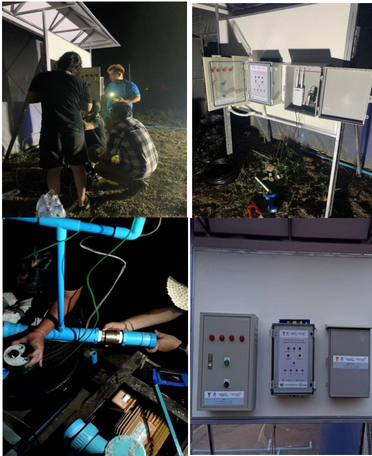
ภาพที่ ๓๔ แสดงการปฏิบัติงานขณะทำการติดตั้งระบบเกษตรอัจฉริยะ
