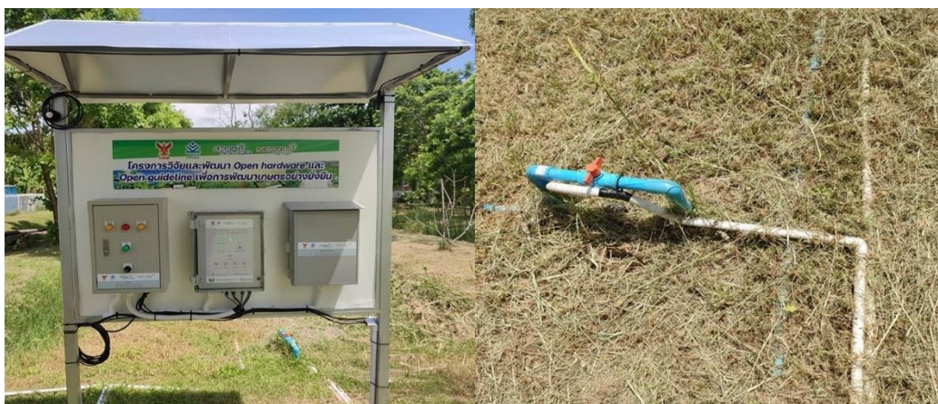
ภาพที่ ๔๗ แสดงสถานีติดตั้งระบบเกษตรอัจฉริยะและชุดท่อน้ำบายพาส สวนมะม่วงพื้นที่เปิดโล่ง แปลงอนุรักษ์สายพันธุ์มะม่วง จังหวัดฉะเชิงเทรา
