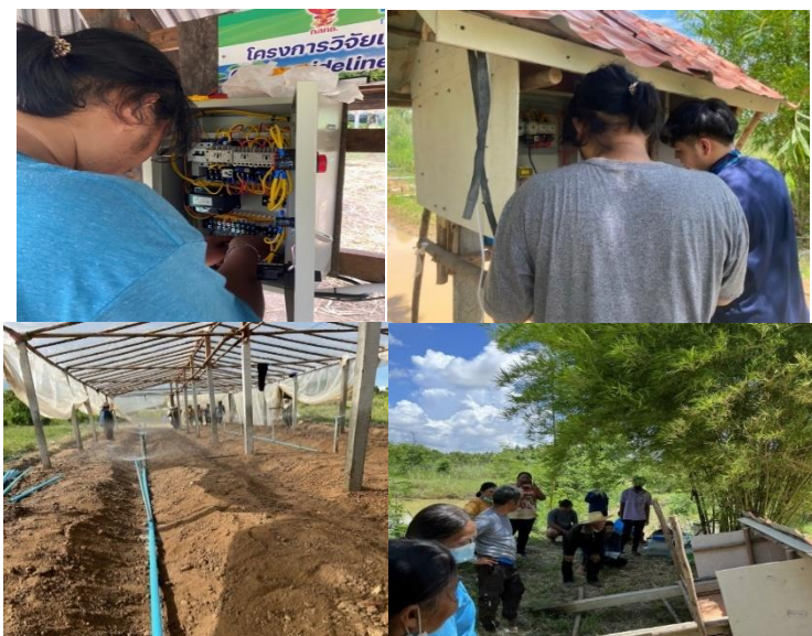
ภาพที่ ๓๗ แสดงการปฏิบัติงานขณะทำการติดตั้งระบบเกษตรอัจฉริยะ ณ ฟาร์มผักสลัดโรงเรือนแบบเปิด จังหวัดนครสวรรค์
