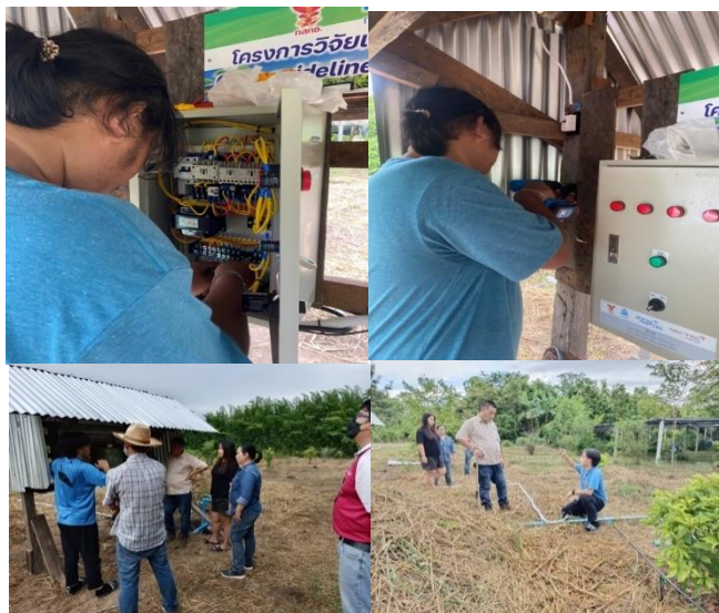
ภาพที่ ๓๘ แสดงการปฏิบัติงานขณะทำการติดตั้งระบบเกษตรอัจฉริยะ ณ สวนพืชผสมผสานพื้นที่เปิดโล่ง จังหวัดนครสวรรค์
