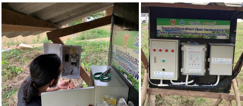
ภาพที่ ๔๐ แสดงการปฏิบัติงานขณะทำการติดตั้งระบบเกษตรอัจฉริยะ ณ สวนก้านันสาคร สวนทุเรียนพื้นที่เปิดโล่ง เขตนวัตกรรมระเบียงเศรษฐกิจพิเศษตะวันออก (EECI) จังหวัดระยอง
