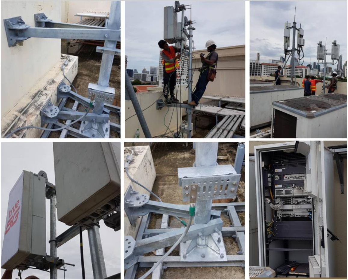
รูป 66 การติดตั้งสถานีฐาน 5G ที่ใช้สำหรับการทดสอบกรณี Outdoor
