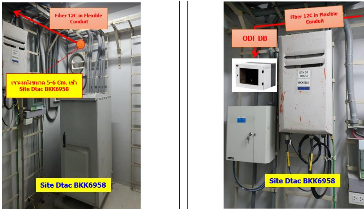
รูป 67 การติดตั้งระบบ Transmission ของ DTAC ให้สถานีฐาน 5G ที่ใช้สำหรับการทดสอบกรณี Outdoor
