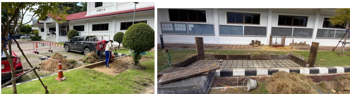
รูปที่ 1-8 การดำเนินการปรับพื้นที่และเข้าแบบฐานเพื่อพร้อมติดตั้ง
