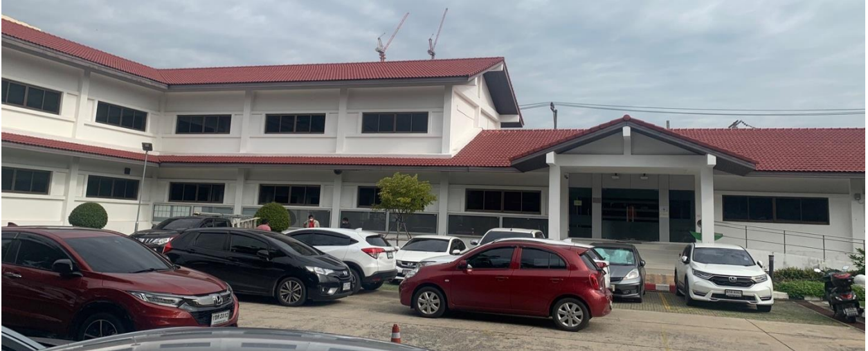
รูปที่ 1-5 พื้นที่ติดตั้งสถานีประจุไฟฟ้า
