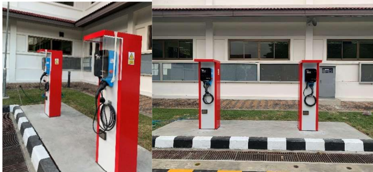
รูปที่ 1-9 สถานีประจุไฟฟ้า (EV Charging Station) ที่เสร็จสิ้นและตรวจรับเรียบร้อยแล้ว
