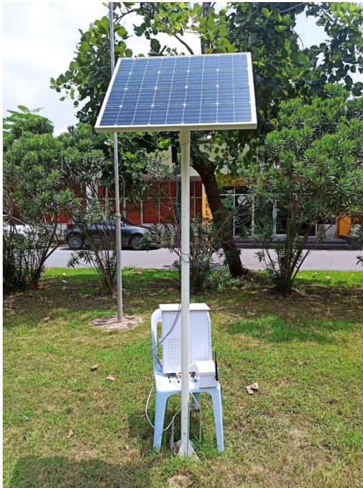
รูปที่ 67 การทดสอบอุปกรณ์เซ็นเซอร์กับระบบพลังงานแสงอาทิตย์
