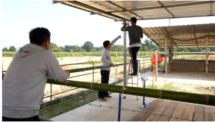
ภาพที่ 4-73 การลงพื้นที่เพื่อติดตั้งกล่อง 5G
