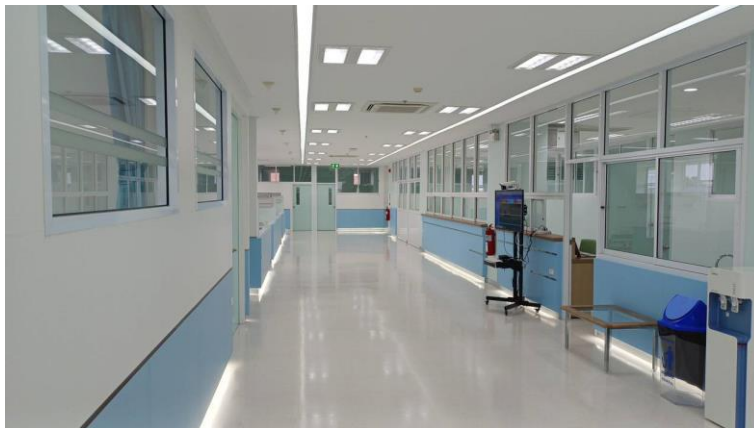
ภาพที่ 6-18 ติดตั้งระบบมอนิเตอร์เครื่องตรวจสอบสัญญาณซีพีทีโรงพยาบาล
