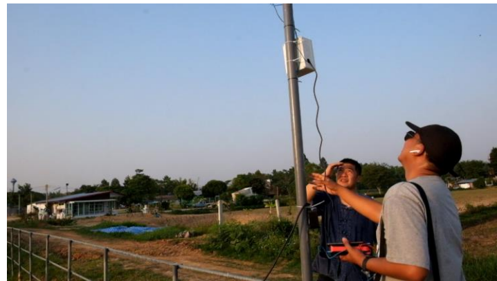
ภาพที่ 4-74 การลงพื้นที่เพื่อติดตั้งชุดตรวจสอบสภาพอากาศ 5G
