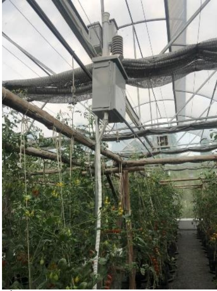
ภาพที่ 33 Wireless module วัดความเข้มแสง อุณหภูมิ ความชื้นอากาศ
