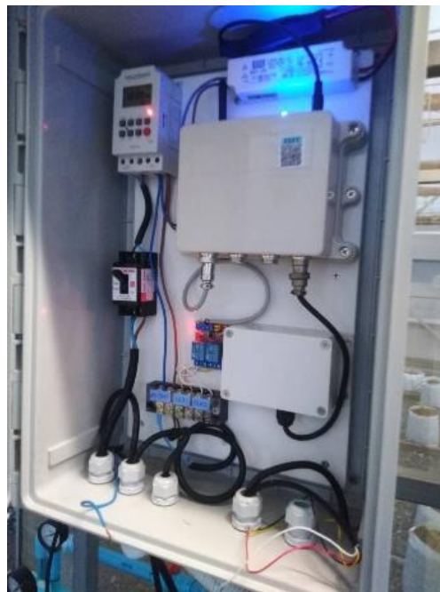
ภาพที่ 53 การติดตั้งอุปกรณ์อ่านค่า/ส่งข้อมูลสำหรับเชื่อมต่อเซ็นเซอร์
