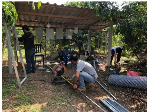
ภาพที่ 17 เกษตรกรเตรียมความพร้อมสถานที่ และระบบไฟฟ้าก่อนการติดตั้ง
