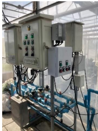
ภาพที่ 31 การติดตั้งอุปกรณ์อ่านค่า/ส่งข้อมูลสำหรับเชื่อมต่อเซ็นเซอร์
