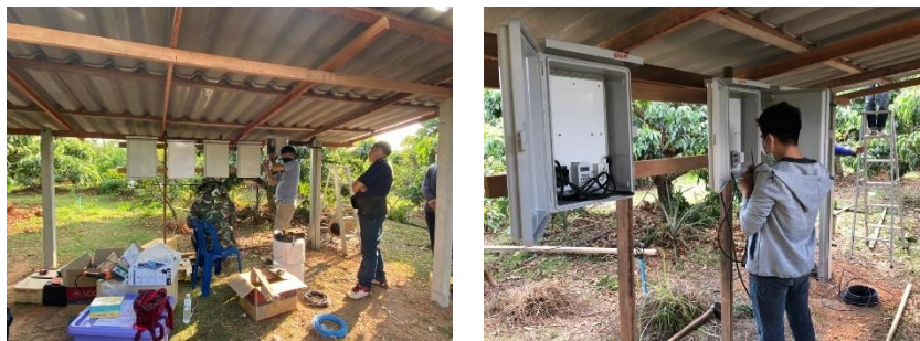
ภาพที่ 21 การติดตั้งอุปกรณ์อ่านค่า/ส่งข้อมูลสำหรับเชื่อมต่อเซ็นเซอร์
