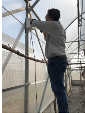
ภาพที่ 52 ระบบไฟฟ้าไปยังตำแหน่งที่ติดตั้งเซ็นเซอร์ และกล้องวงจรปิด CCTV ภายในแปลง
