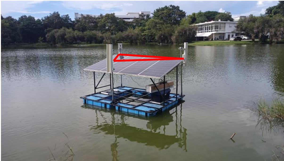
ภาพที่ 7.8 การติดตั้งเสากระจายสัญญาณจริง
