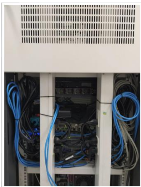
รูปที่ 15 สวิตช์ และเครื่องแม่ข่ายที่ดำเนินการติดตั้งไซตซ์ขอนแก่น (2)
