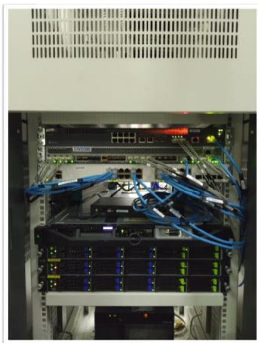
รูปที่ 14 สวิตช์ และเครื่องแม่ข่ายที่ดำเนินการติดตั้งไซตซ์ขอนแก่น (1)
