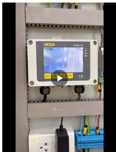
รูปที่ ๑๐๘ ตรวจสอบความแม่นยำในการถอดรหัสจากจอมอนิเตอร์ของ VEGA sensor
