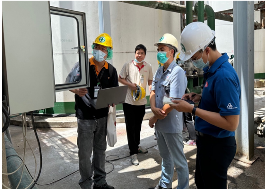
รูปที่ ๑๐๔ การติดตั้งอุปกรณ์สำหรับ Edge Computing ใกลิโซโลน้ำมันที่ต้องการตรวจวัด
