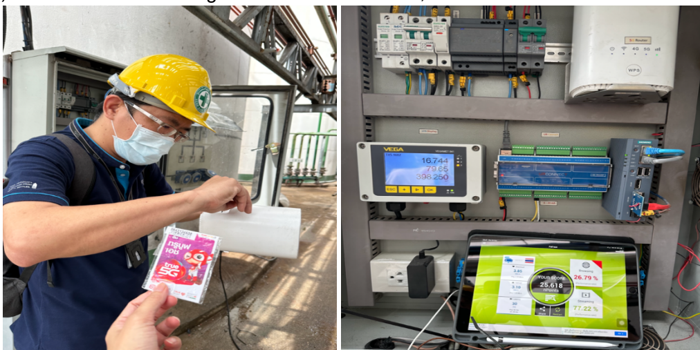
รูปที่ ๑๒๔ การทดสอบระบบและความเร็วของสัญญาณ 5G ที่ใช้ในการสื่อสาร
