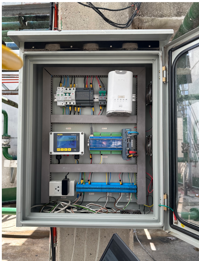
รูปที่ ๑๐๕ ตู้เก็บอุปกรณ์สำหรับ Edge Computing ที่ออกแบบให้ทนความร้อนและความชื้น เพื่อติดตั้งกลางแจ้ง มีระบบไฟฟ้าสำหรับจ่ายอุปกรณ์ IT ต่างๆ ภายในตู้และพัฒนาระบายความร้อน 4 ตัวรอบทิศทาง
