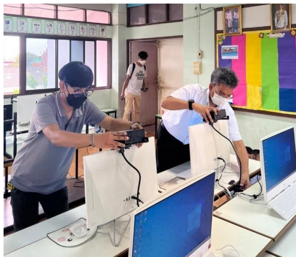
ภาพที่ 4-51 ดำเนินการติดตั้งอุปกรณ์ในห้องคอมพิวเตอร์
