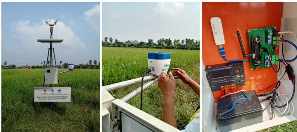
รูปที่ 90 การติดตั้งในแปลง 1 จังหวัดสุพรรณบุรี
