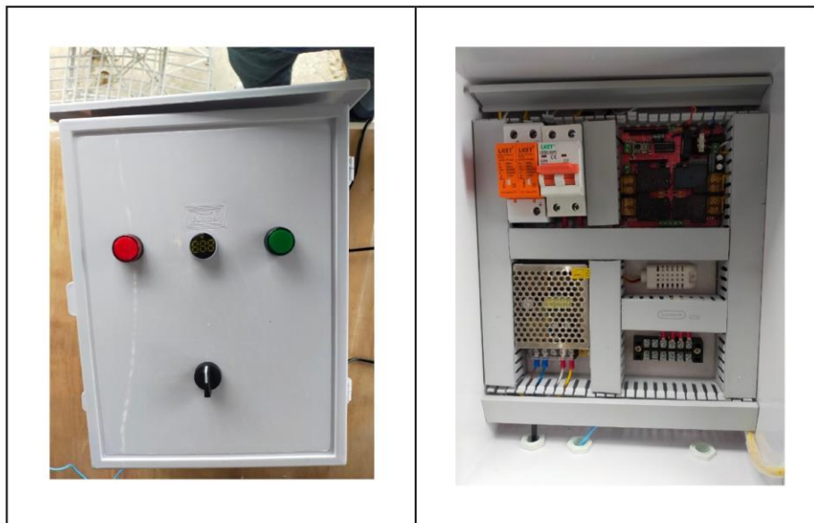
ภาพการติดตั้ง
