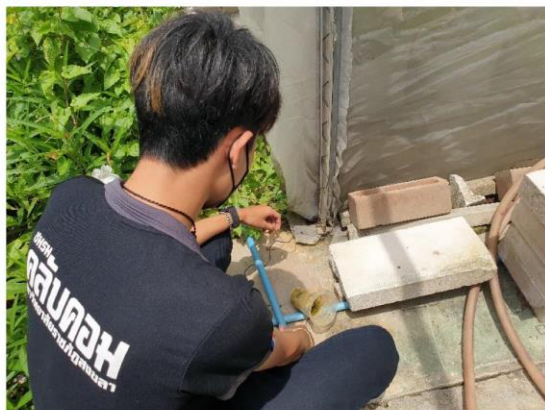
รูปที่ 2 การตัดต่อท่อน้ำระบบเดิม
