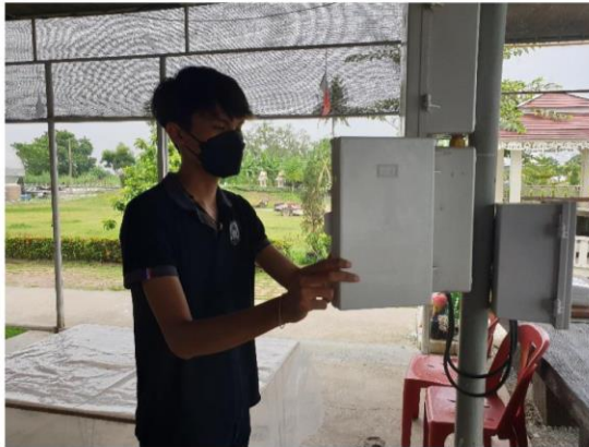
รูปที่ 1 การติดตั้งตู้ควบคุม
