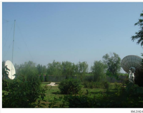
รูปที่ 35 ภาพจานรับสัญญาณสำรอง (backup) ขนาด 7.3 เมตร
